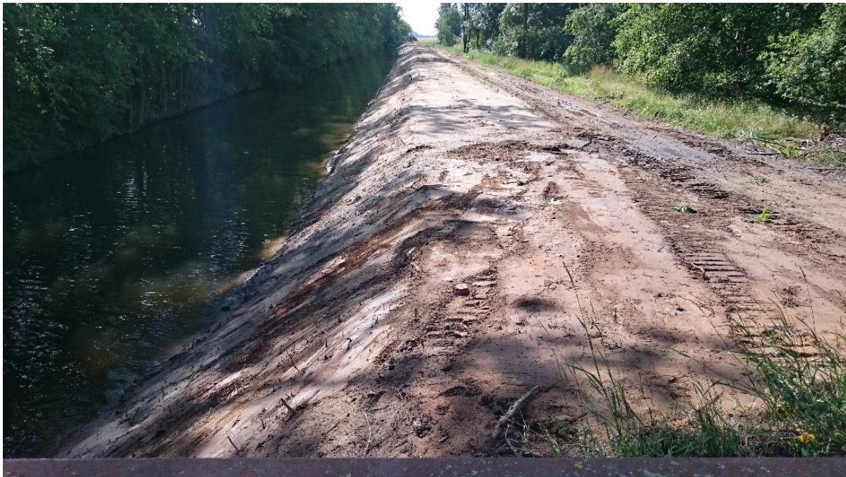
Abb. 4 und 5: Umsetzung des Gewässerausbaus und Herstellung eines geeigneten
