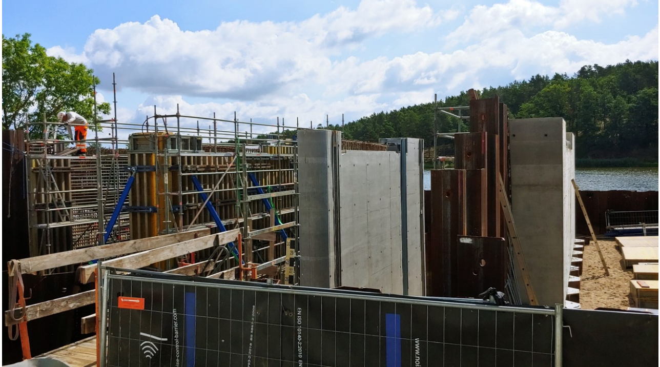
Abb. 7: Pfeiler und Widerlager Süd betoniert und ausgeschalt; Pfeiler und Widerlager Nord eingeschalt, Betonage in Vorbereitung (Foto: Habermann, LfU W21, 25.07.2023)
