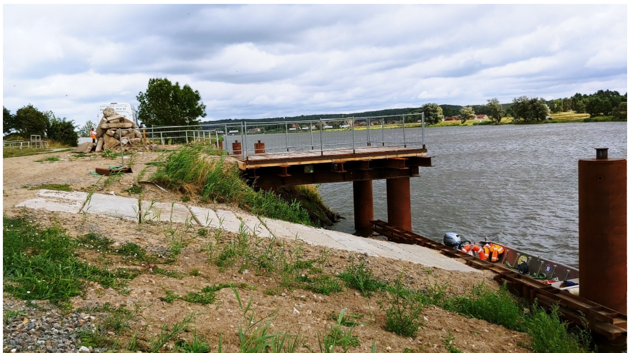
Abb. 7: Schiffsanleger südlich/oberhalb der Baustelle
