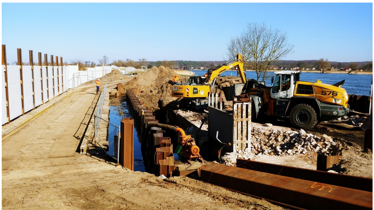
Abb. 5: Abbruch der alten Bauwerksreste; links die landseitige Lärmschutzwand (Foto: Fromhold-Treu, LfU W21, 02.03.2022)
