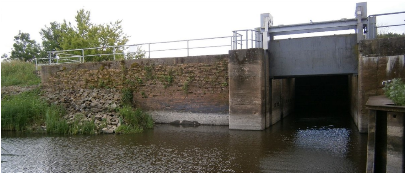
Abb. 2: Gesamtansicht vom Südufer Wrechsee mit geöffneter Kahnschleuse
