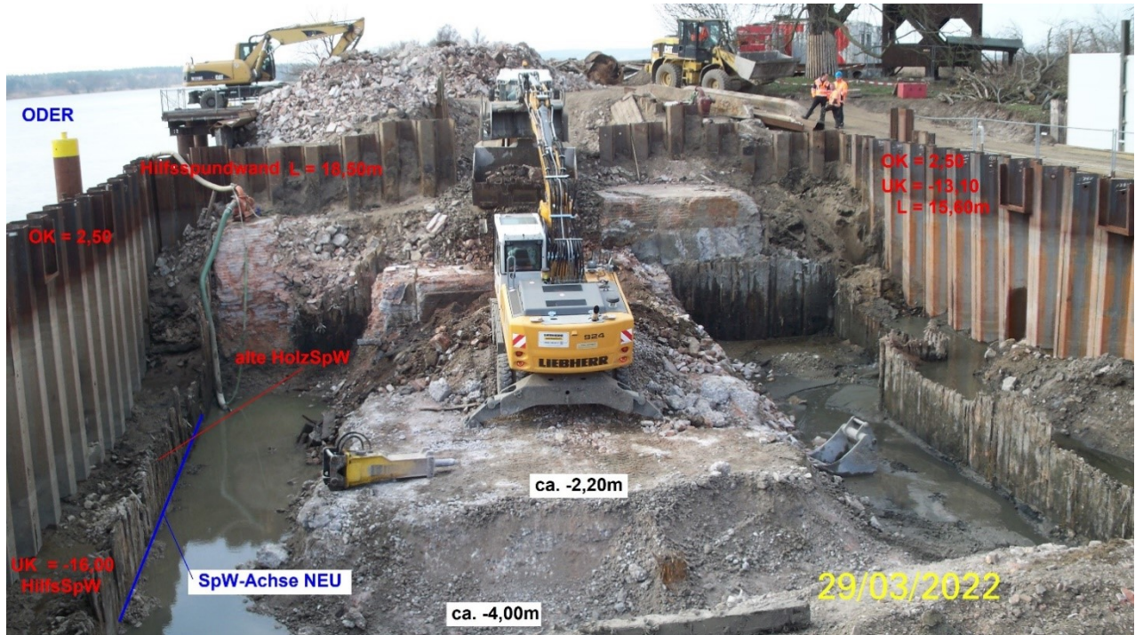
Abb. 6: Abbruch des Altbauwerkes in der Baugrube
