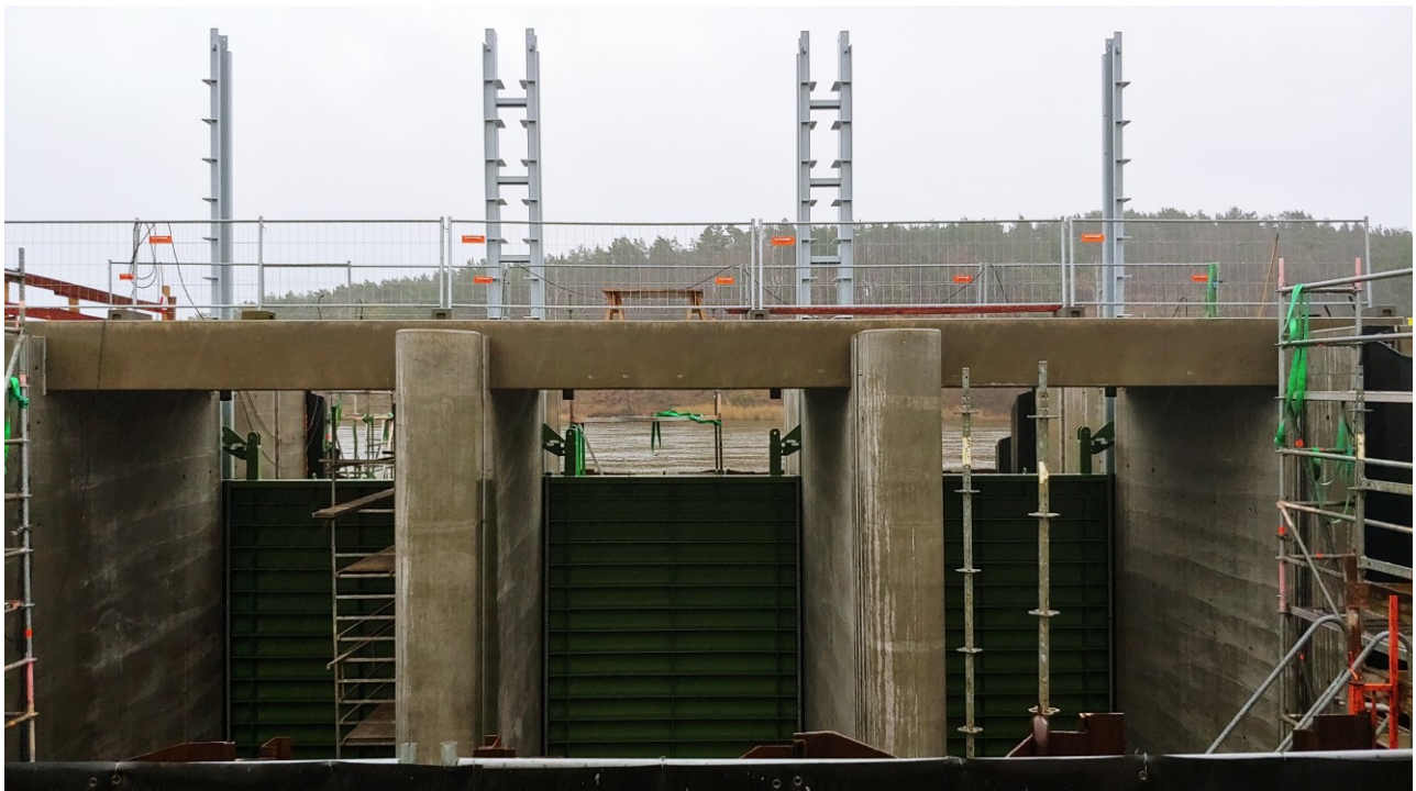
Abb. 7: Brückenüberbau fertiggestellt und ausgeschalt, Führungsrahmen und Schütztafeln eingebaut (Foto: Habermann, LfU W21, 19.12.2023)
