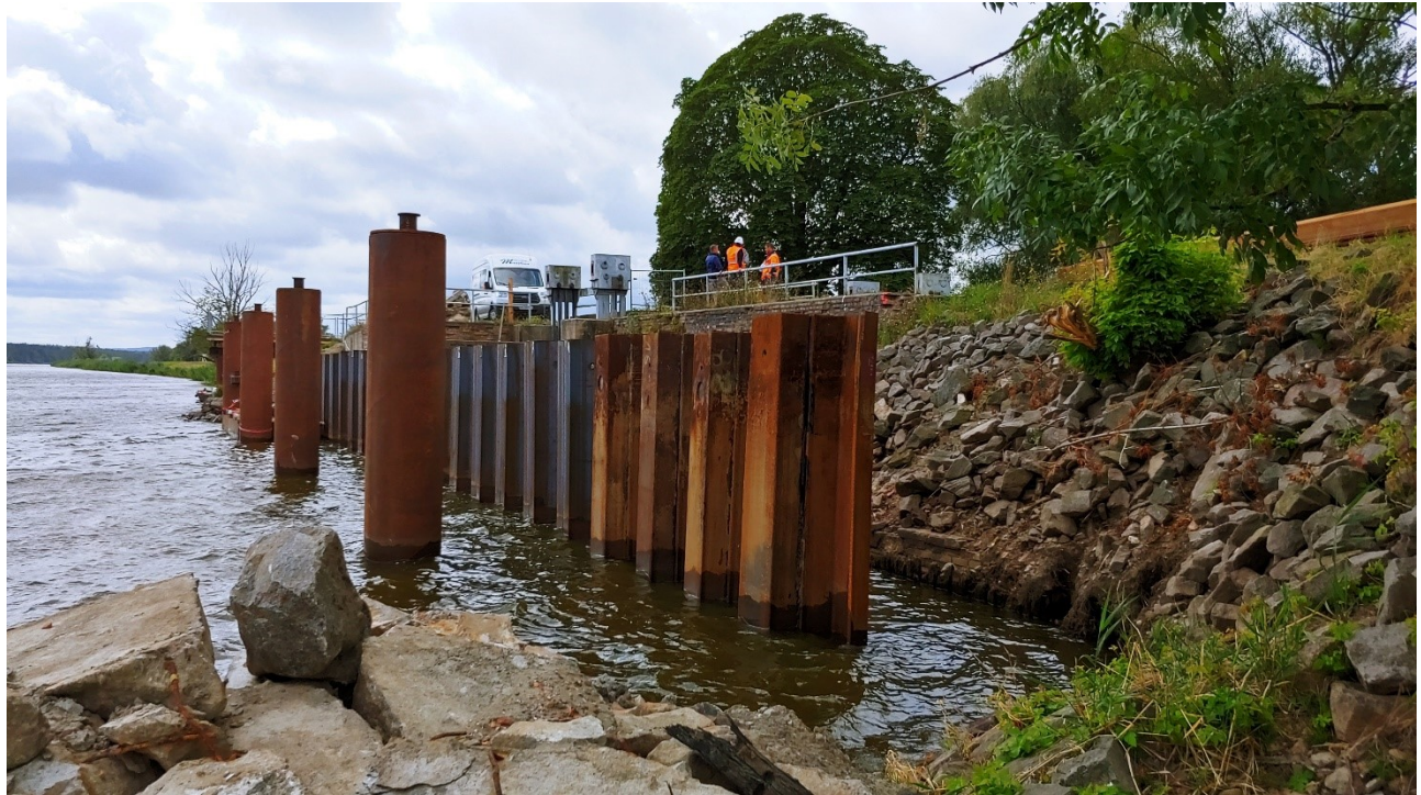
Abb. 4: Vier Anlegedälben sowie die wasserseitige Hilfsspundwand für den Abbruch der in die Oder ragenden Bauwerksreste (Foto: Habermann, LfU W21, 17.08.2021)
