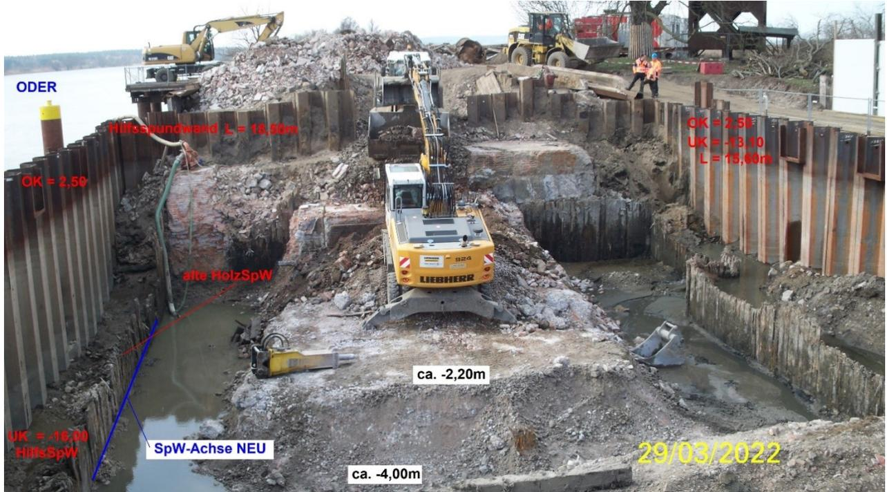
Abb. 6: Abbruch des Altbauwerkes in der Baugrube
