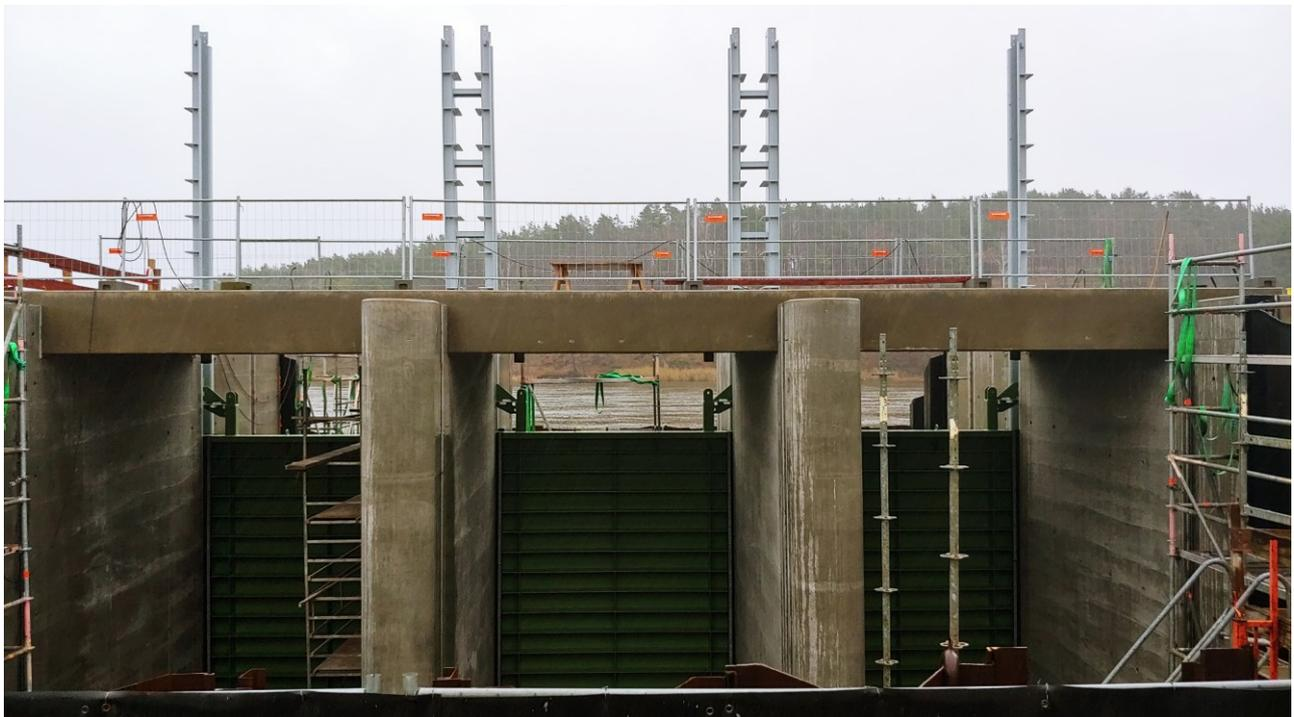
Abb. 7: Brückenüberbau fertiggestellt und ausgeschalt, Führungsrahmen und Schütztafeln eingebaut
