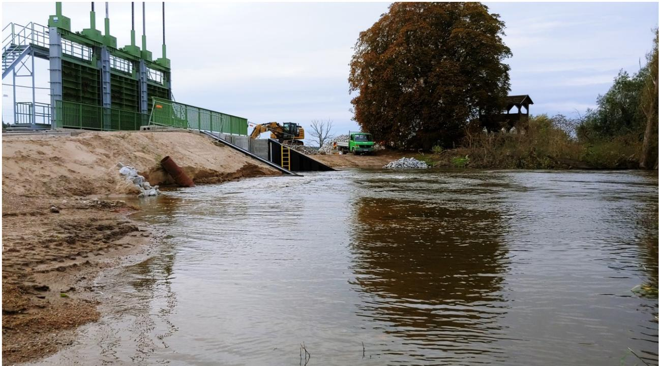
Abb. 9: Hochwassersituation: Bauwerk geöffnet, Polder durchströmt; Wasserstand deutlich oberhalb Holm Flügelwände
