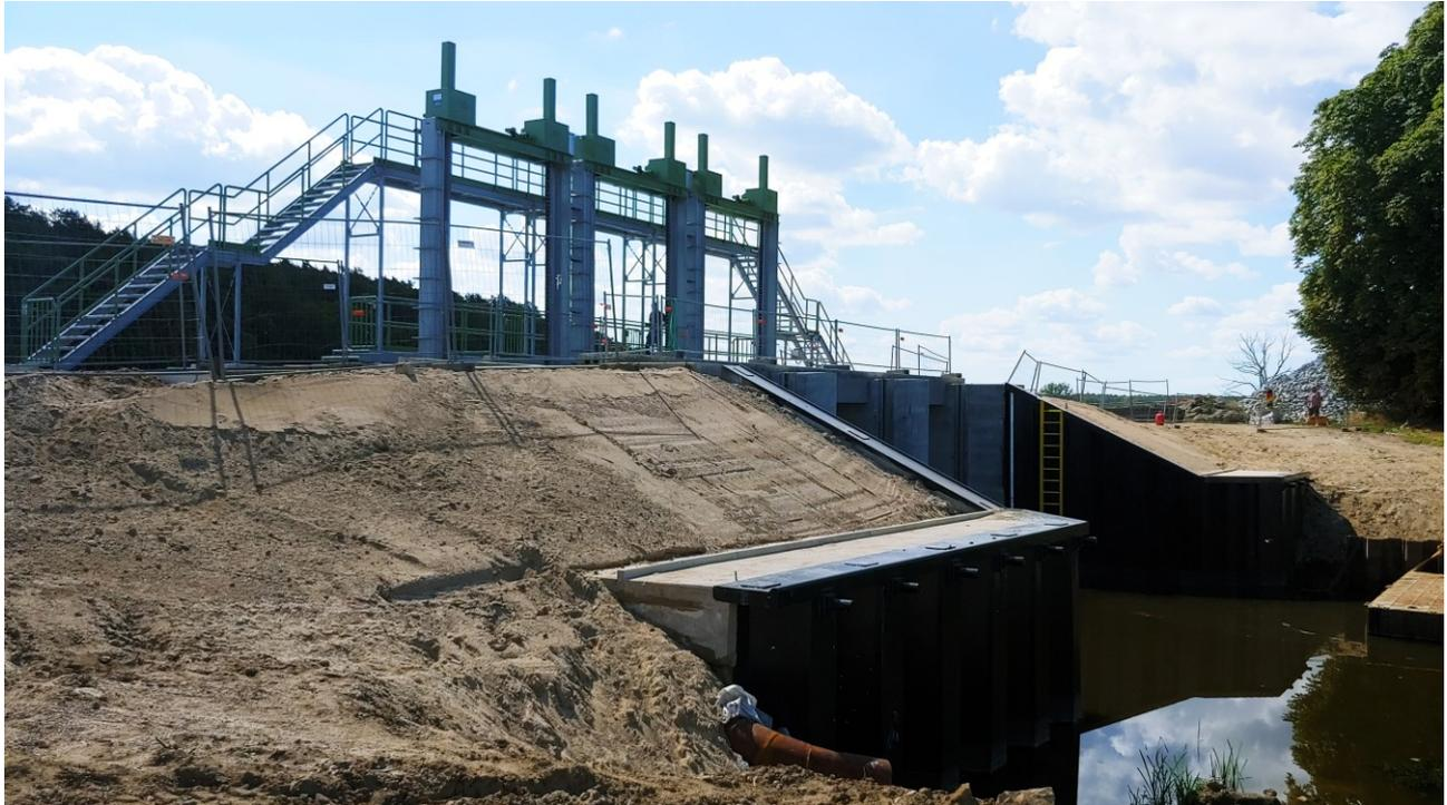
Abb. 8: Zustand nach erfolgreicher Funktionsprobe nass/trocken; Stahlwasserbau fertiggestellt, Schütztafeln und Bediensteg montiert, Böschungsgestaltung begonnen
