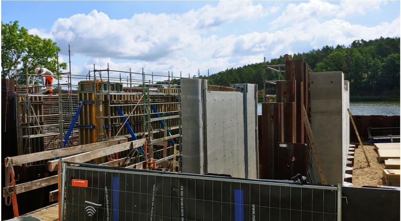
Abb. 7: Pfeiler und Widerlager Süd betoniert und ausgeschalt; Pfeiler und Widerlager Nord eingeschalt, Betonage in Vorbereitung
