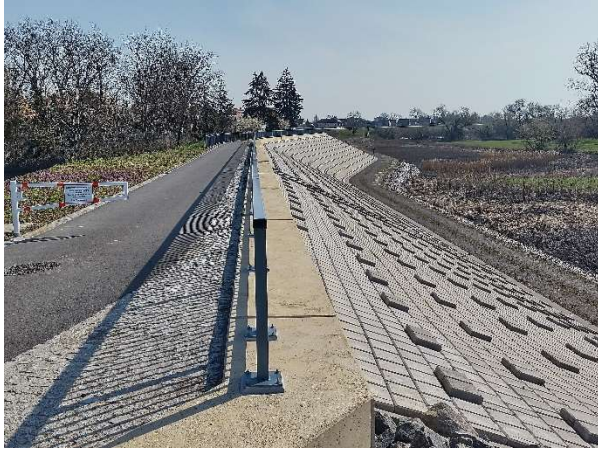
Bild 3: Böschungssicherung mit Deckwerksteinen
