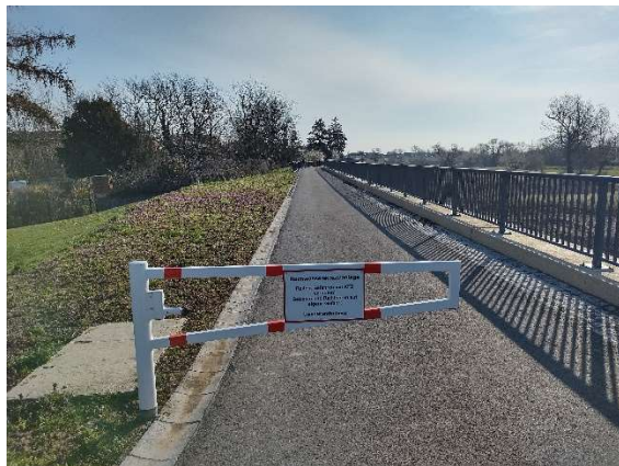
Bild 1: DVW Böschungskrone am Hafen
