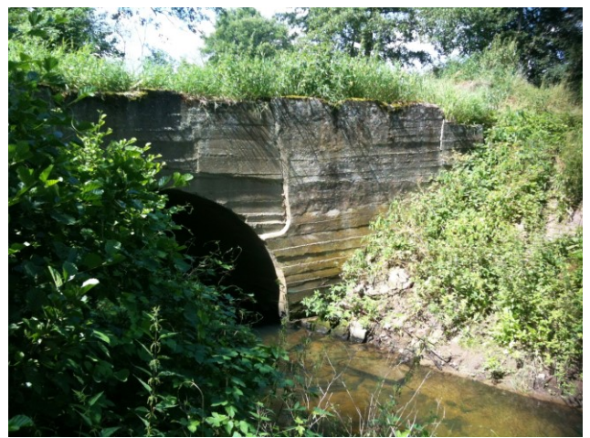
Foto 4 Brücke mit Sohlbereich
