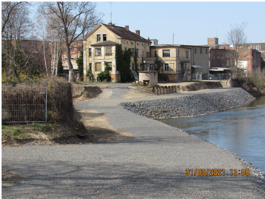
Bild 2: Baustraße zur Umsetzung der Maßnahmen
