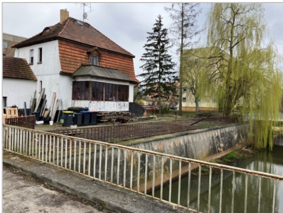
Abb. 16 – 5. Bauabschnitt, Bestand Uferwand, Blick von Brücke 3 kanalabwärts in Richtung Südosten (Gewässer-km 0+873), Foto: LfU Referat W 25, März 2023
