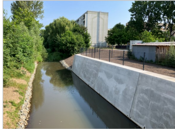
Abb. 15 – 5. Bauabschnitt, umgebaute Uferwände, Blick von Brücke 3 kanalaufwärts in Richtung Norden (Gewässer-km 0+873), Foto: LfU Referat W 25, Juni 2024
