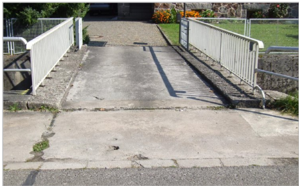
Abb. 19 – Brücke 5, Bestand, Blick von Friedrich-Ludwig-Jahn-Straße in Richtung Osten (Gewässer-km 1+380), Foto: BDC Dorsch Consult GmbH, September 2013
