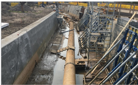
Abb. 4 – 1. Bauabschnitt, Herstellung neuer Uferwandblöcke (blockweise Bewehrungs-, Schalungs- und Betonierarbeiten), Blick von Brücke Herzberger Straße kanalabwärts in Richtung Süden (Gewässer-km 1+650), Foto: LfU Referat W 25, März 2022
