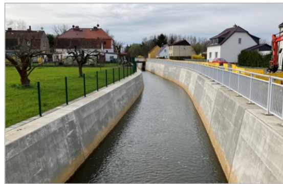
Abb. 5 – 1. Bauabschnitt, umgebaute Uferwände, Blick von Brücke Herzberger Straße kanalabwärts in Richtung Süden (Gewässer-km 1+650), Foto: LfU Referat W 25, März 2023
