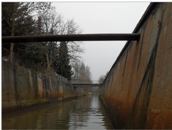
Abb. 8 – 3. Bauabschnitt, Bestand Uferwände, Blick von Sohle kanalabwärts in Richtung Süden (Gewässer-km 1+425), Foto: BDC Dorsch Consult GmbH, September 2013
