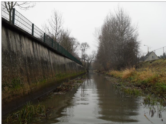
Abb. 12 – 4. Bauabschnitt, Bestand Uferwand, Blick von Sohle kanalabwärts in Richtung Süden (Gewässer-km 1+190), Foto: BDC Dorsch Consult GmbH, September 2013
