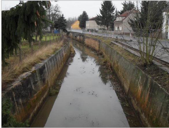
Abb. 2 – 1. Bauabschnitt, Bestand Uferwände, Blick von Brücke Herzberger Straße kanalabwärts in Richtung Süden (Gewässer-km 1+650), Foto: BDC Dorsch Consult GmbH, September 2013
