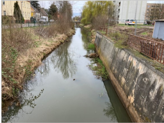
Abb. 14 – 5. Bauabschnitt, Bestand Uferwand, Blick von Brücke 3 kanalaufwärts in Richtung Norden (Gewässer-km 0+873), Foto: LfU Referat W 25, März 2023
