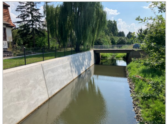
Abb. 17 – 5. Bauabschnitt, umgebaute Uferwände, Blick von Brücke 3 kanalabwärts in Richtung Süden (Gewässer-km 0+873), Foto: LfU Referat W 25, August 2024
