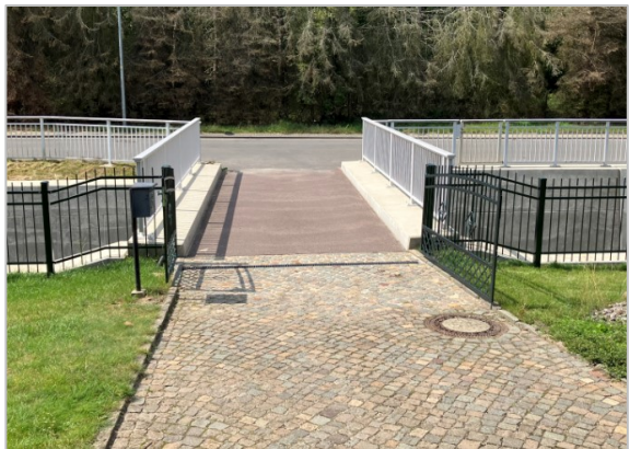
Abb. 21 – Brücke 5, hergestellter Ersatzneubau Überbau, Blick von Anliegergrundstück Friedrich-Ludwig-Jahn-Straße in Richtung Westen (Gewässer-km 1+380), Foto: LfU Referat W 25, August 2024
