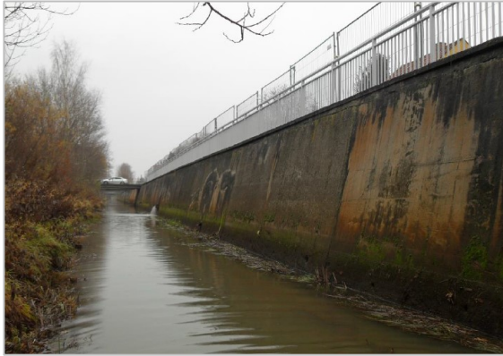
Abb. 6 – 2. Bauabschnitt, Bestand Uferwand, Blick von Sohle kanalabwärts in Richtung Süden (Gewässer-km 1+525), Foto: BDC Dorsch Consult GmbH, September 2013
