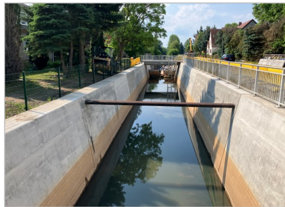
Abb. 9 – 3. Bauabschnitt, umgebaute Uferwände, Blick von Brücke 6 kanalabwärts in Richtung Süden (Gewässer-km 1+428), Foto: LfU Referat W 25, Juni 2023
