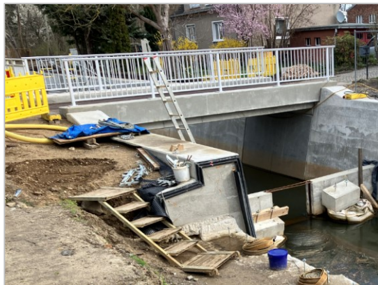
Abb. 20 – Brücke 5, hergestellter Ersatzneubau Überbau, Blick von Friedrich-Ludwig-Jahn-Straße in Richtung Nordost (Gewässer-km 1+370), Foto: LfU Referat W 25, März 2023
