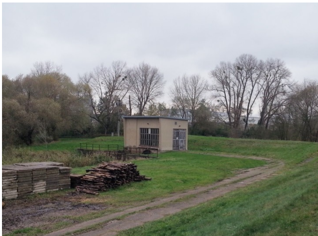
Bild 3: Schöpfwerk Schlosswiesenpolder bei Station 1+980
