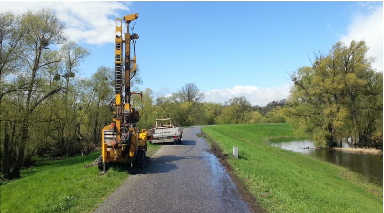
Abb. 6: Deich bei Station 14+100 mit Bohrgerät zur Baugrunderkundung, Blickrichtung Nordwest
