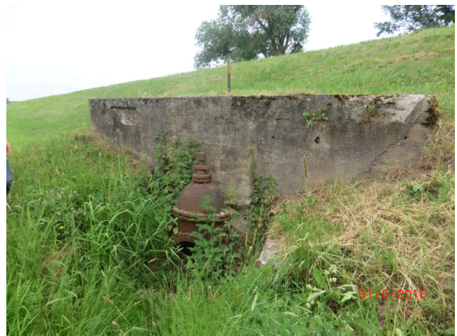
Foto 2: Siel bei Station 13 + 460
