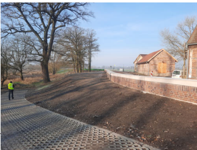
Bild 2: Verklankerte HWS-Wand mit landseitiger Dorf- straße während der Pflasterarbeiten
