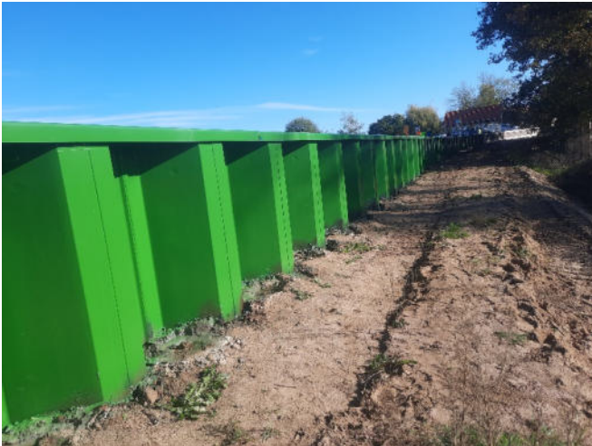
Bild 1: freistehende Spundwand am Bauanfang
