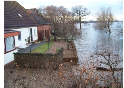
Bild 3 Gehöfte innerhalb des künftigen Ringdeiches TA 2, HW 2011
