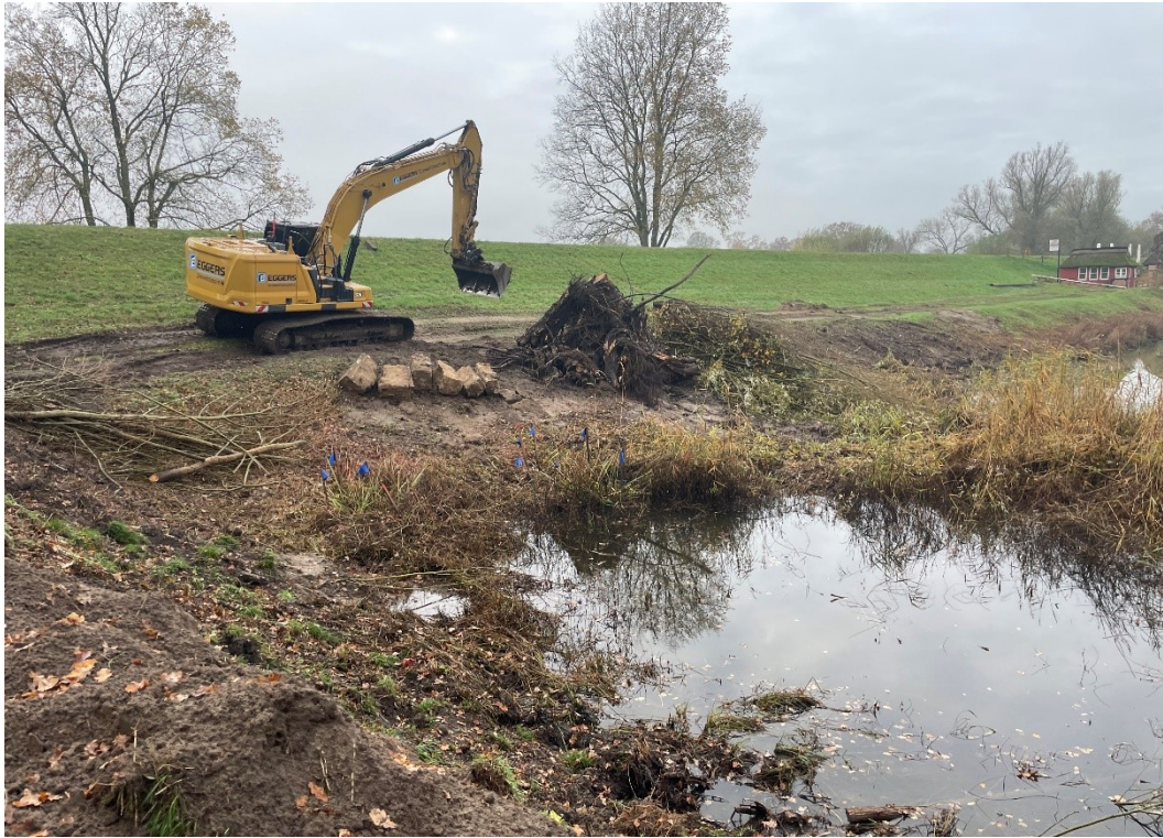
Abb. 7: Rückbau Betonfundament Berme; blaue Fähnchen: Sumpfschwertlilien und Röhricht (© K. Zedler, LfU W21, 12.11.2024)
