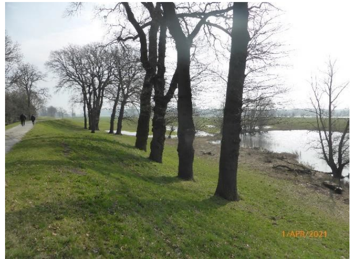
Abb. 6: Deich am Wilkens Brack vor Beginn der Arbeiten, wasserseitige Böschung mit Eichenreihe (Blickrichtung Ost)
