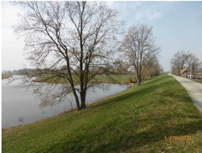
Abb. 5: Deich am Wilkens Brack vor Beginn der Arbeiten, wasserseitige Böschung mit Solitäräumen (Ulme) (Blickrichtung West)
