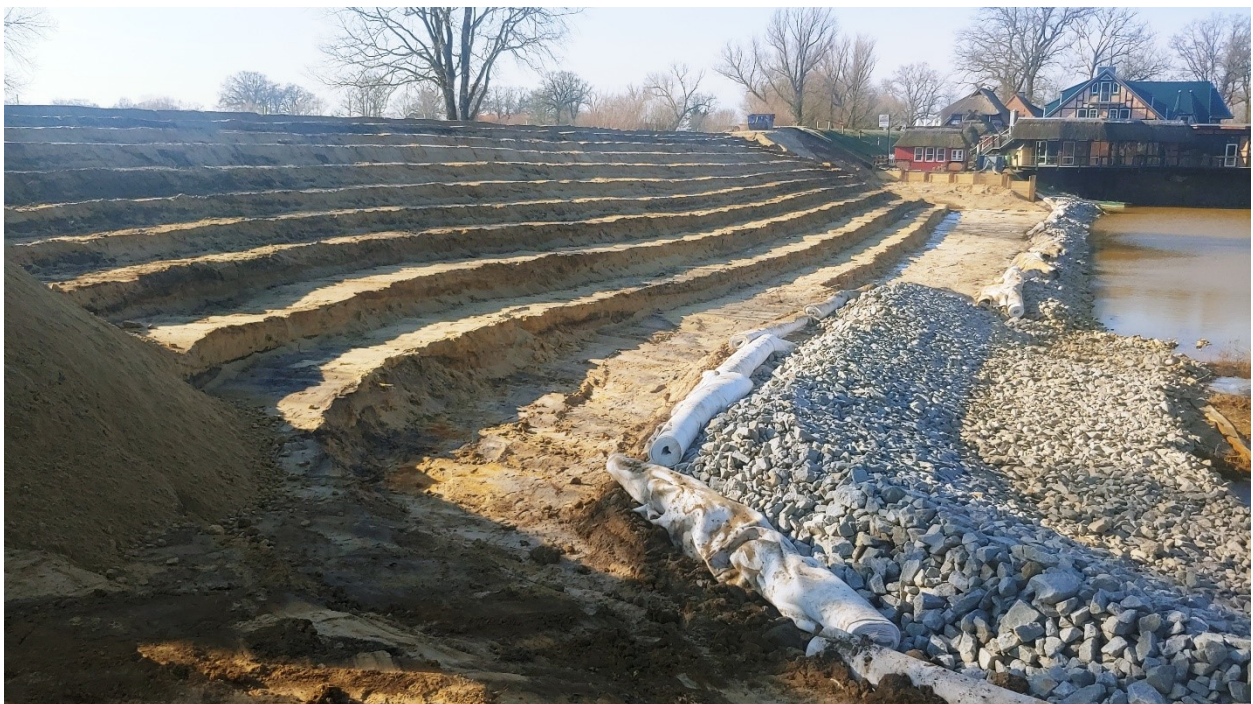
Abb. 10: Ruhende Baustelle; hohe Wasserstände und Frost verhindern die Fortsetzung der Arbeiten am landseitigen Deichfuß (© T. Habermann, LfU W21, 20.02.2025)
