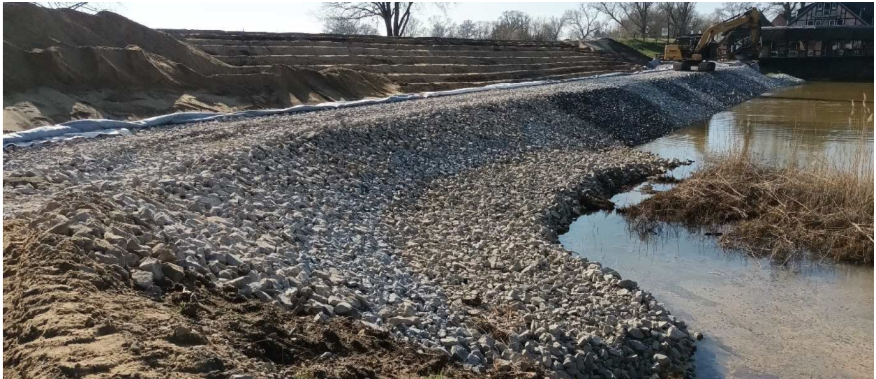
Abb. 11: Wasserbausteinschüttung (WBS) Berme fertiggestellt (© U. Ode, PPN ÖBÜ, 04.03.2025)
