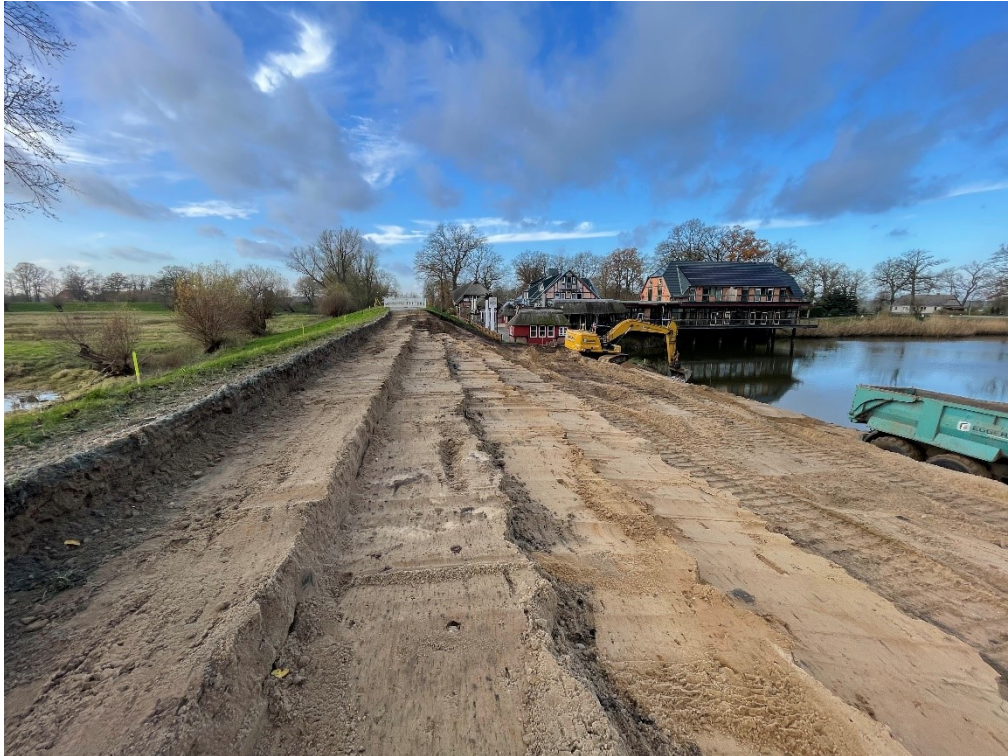
Abb. 9: Altdeich nach Abtrag und Herstellung Abtreppung (© K. Zedler, LfU W21, 26.11.2024)
