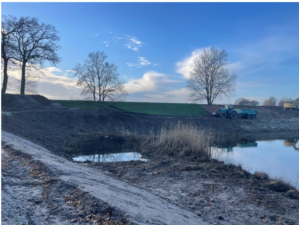
Abb. 8: Abtrag Altdeich, Station 0+000 bis 0+040 (© K. Zedler, LfU W21, 26.11.2024)
