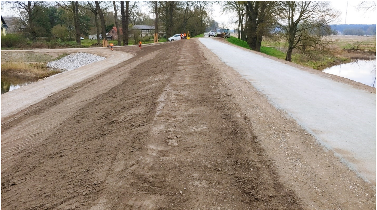
Abb. 13: Fertiggestellter Deich mit Deichverteidigungsweg auf der Deichkrone und beidseitigen Banketten; landseitige Deichschulter mit Überbreite für spätere Deicherhöhungen (© T. Habermann, LfU W21, 08.04.2025)
