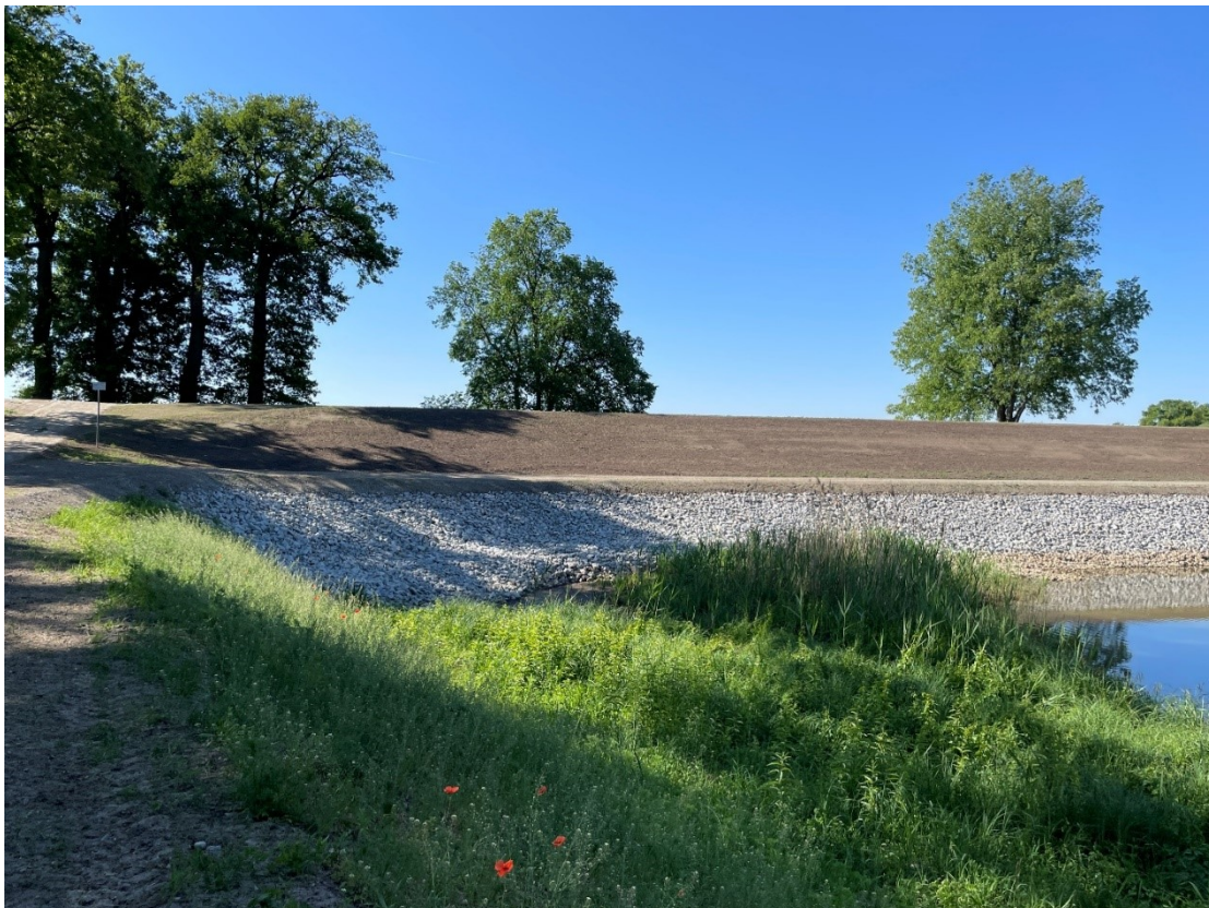
Abb. 14: Fertiggestellter Deich mit langsam auflaufender Ansaat (© K. Zedler, LfU W21, 13.05.2025)
