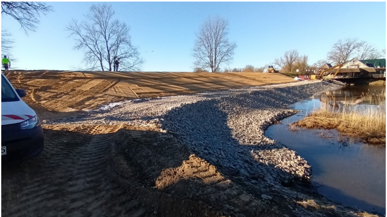
Abb. 12: Einbau Stützkörperschichten bis Deichkrone abgeschlossen (© U. Ode, PPN ÖBÜ, 17.03.2025)
