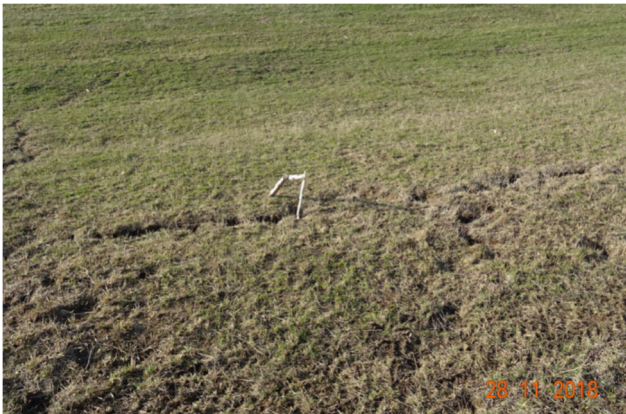
Foto 3: Wasserseitige Böschungsriffe
