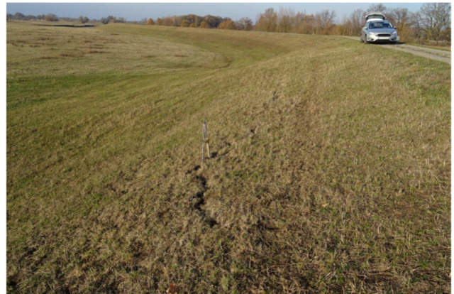
Foto 4: Wasserseitige Böschungsriffe
