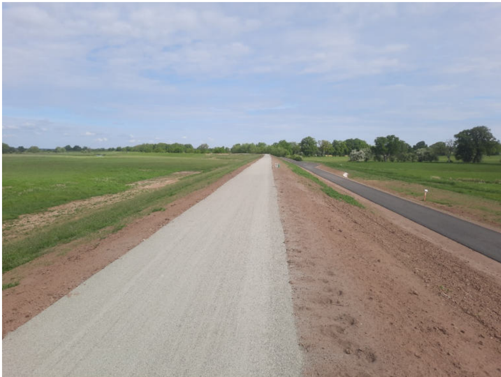
Foto 5 und 6: fertig gestellter Deich
