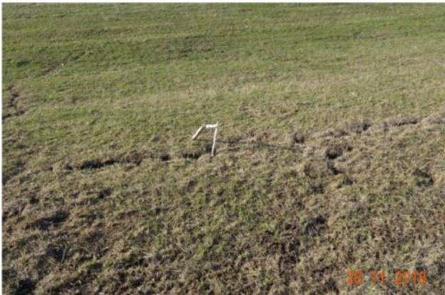
Foto 3: Wasserseitige Böschungsriss
