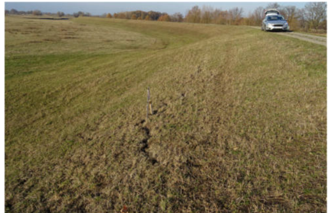
Foto 4: Wasserseitige Böschungsriss
