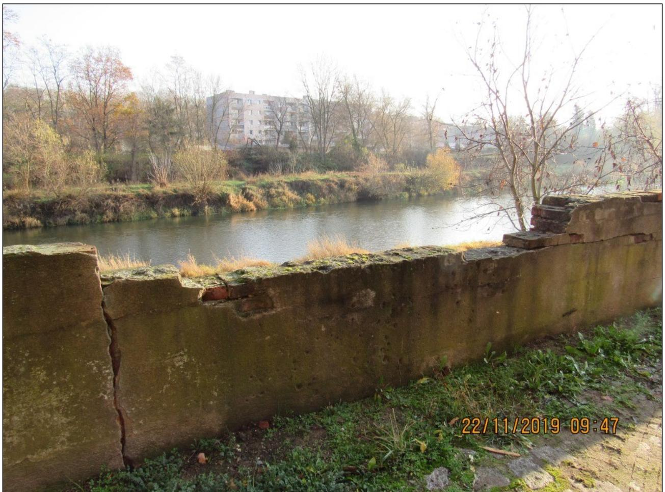
Abbildung 1- beschädigte und einsturzgefährdete Hochwasserschutzwand im Teilobjekt 3
