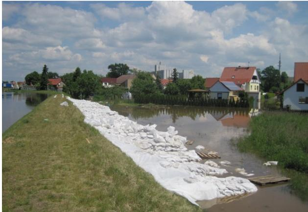
Foto 5 - Deichsicherung mit Sandsäcken [LfU, 2013]
