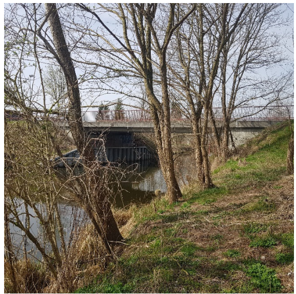
Abb. 7 – Ruppiner Kanal, km 13+900 Brücke L 19 Kremmen, Foto: WBL, April 2022
