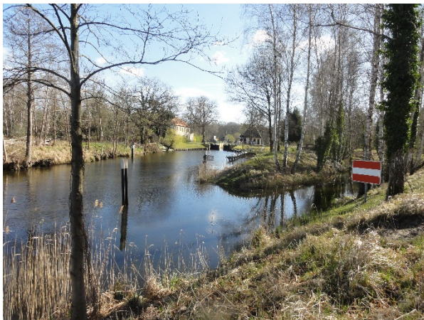
Abb. 2 – Bauende Oberwasser – Schleuse Hohenbruch (Ruppiner Kanal km 7,1), Foto: WBL, April 2022
