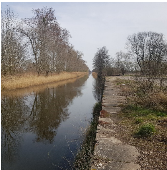
Abb. 6 – Ruppiner Kanal, km 13+87, Bollwerk Kremmen, Foto: WBL, April 2022
