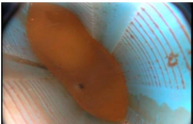
Abbildung 6: zusammengedrücktes Filterrohr
