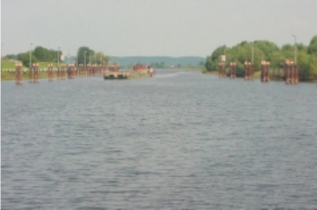
Foto 10: Die Oder ist zur Bundeswasserstraße ausgebaut. Der Fluss wurde begradigt, die Ufer sind beinahe durchgängig verbaut, und Deiche dienen als Hochwasserschutz.
