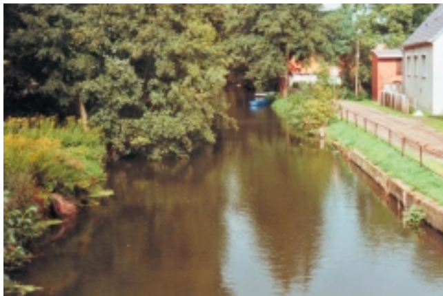
Foto 2: Einseitiger Steinuferverbau in der Ortschaft Hohenofen am Unterlauf der Dosse. Das linksseitige Ufer hingegen ist von einer naturnahen Vegetation bestanden.
