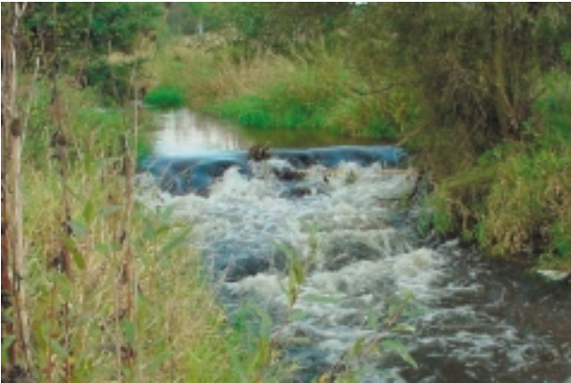
Foto 11: Sohlschwelle in der Pulsnitz oberhalb der Ausleitung in den Mühlengraben bei Koppen. Das Querbauwerk verhindert eine uneingeschränkte Migration der Wasserlebewesen.
