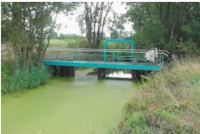
Foto 4: Wehr in der Seelake östlich von Seelow. Das Querbauwerk verursacht einen Rückstau des Wassers flussaufwärts, der sich über mehrere Kilometer erstrecken kann. In Extremfällen ist Wasserstillstand oder sogar eine zeitweise Umkehr der Fließrichtung möglich. Als Folge können, bedingt durch die verringerte Fließgeschwindigkeit, für Fließgewässer untypische Algenblüten auftreten.
