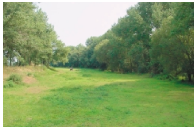
Foto 6: Deich (links im Bild) mit Vorland und standortgerechtem Uferbewuchs an der Güstebieser Alten Oder bei Neukietz. Das Hochwasserschutzbauwerk beeinträchtigt das natürliche Überschwemmungsverhalten des Fließgewässers. Das Vorland wertet das Bauwerk auf, da zumindest eine eingeschränkte Ausuferung möglich ist.
