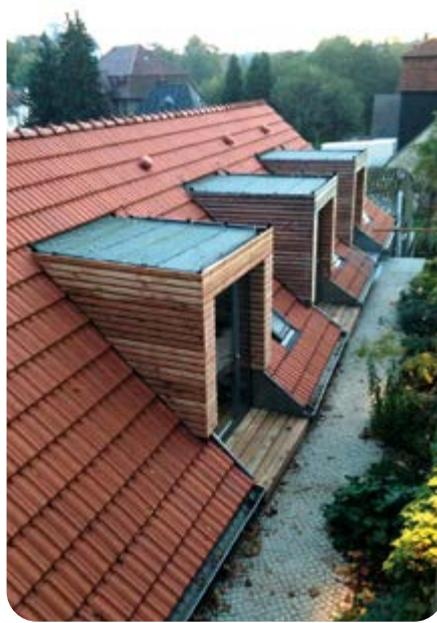
Abbildung 6: Dach mit Gauben
