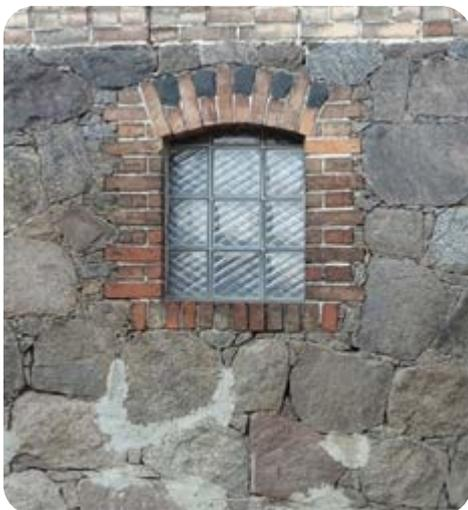
Abbildung 81: Fenster in Feldsteinmauerwerk
