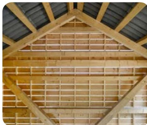
Abbildung 53: Holzelemente Wand
