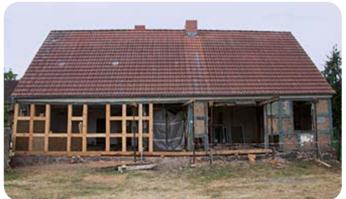
Abbildung 19: Sanierung des Ständerwerks
