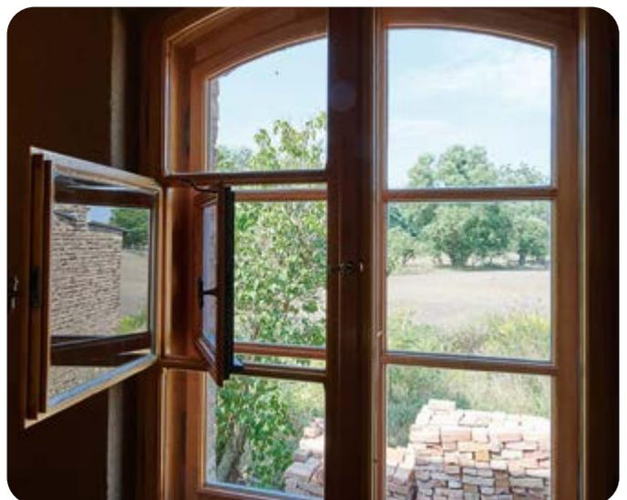
Abbildung 27: Doppelkastenfenster mit Lüftungsflügel
