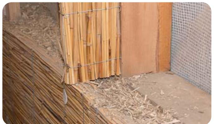
Abbildung 21: Sanierung - Dämmung
