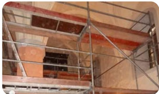
**Abbildung 90: Notsicherungsarbeiten**
