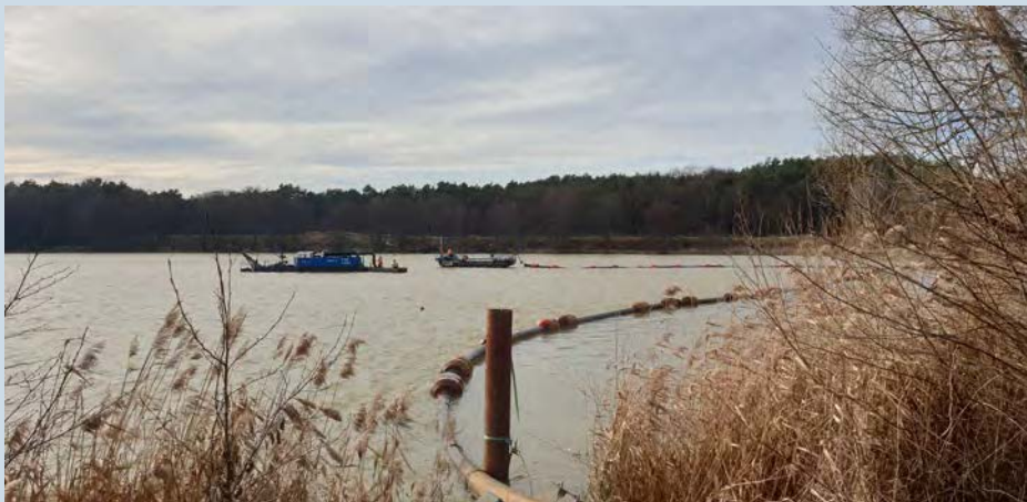
Saug- und Spültechnik der Firma TWB an der Vorsperre Bühlow (01/2021) (Foto: Marius Schlösser, LMBV (2021))
