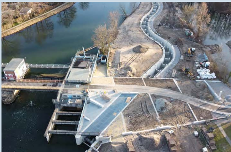
Baustelle des Schlitzpasses am Großen Spreewehr (Foto: Markus Grimm, Lausitzer und Mitteldeutsche Bergbauverwaltungsgesellschaft mbH)
