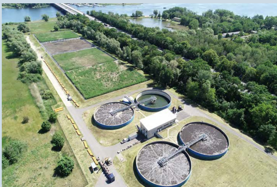
Kläranlage Werder, SBR-Becken mit Maschinenhaus und Klärschlammvererdungsbecken © Wasser- und Abwasserzweckverband Werder-Havelland (Foto: Alexander Korn, WAZV Werder-Havelland)
