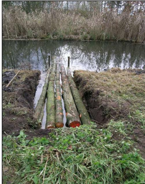
Mehrlagig eingebaute Stämme mit Reisigunterlage und Kies am Bühnenkopf.
