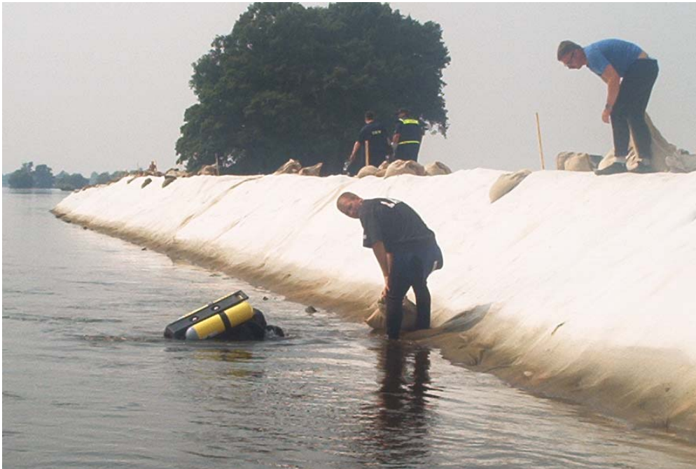
IX. Deichbauabschnitt bei Jagel (Landkreis Prignitz) am 24.08.02: Die wasserseitige Deichböschung wird mit Unterstützung der Bundeswehr zusätzlich gesichert.
