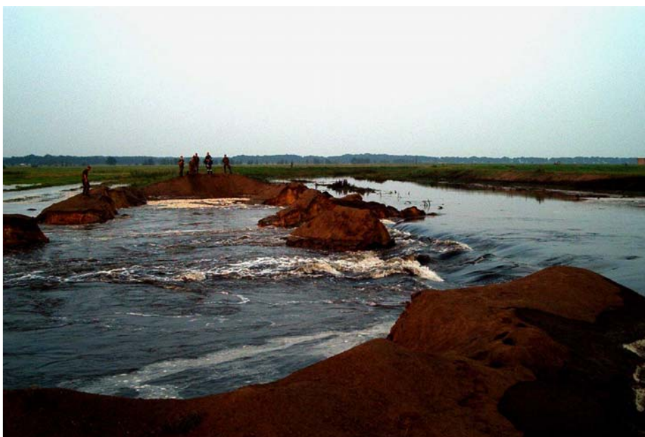
Havelpolder "Flöthgraben" am 22.08.02 - eine Stunde nach Sprengung des Deiches
