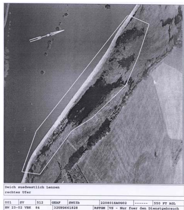
Abb. 14: Dieselbe Deichgefahrenstelle auf dem Luftbild
