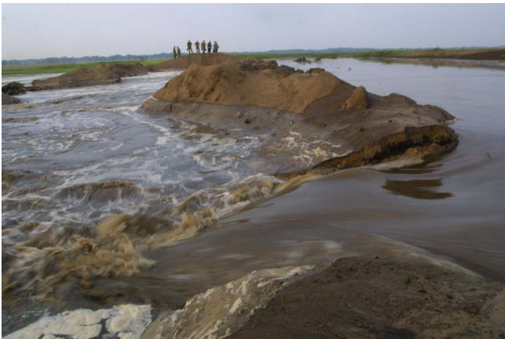
Polder "Flöthgraben" am 22.08.02, 18:55 Uhr: Mit der Flutung erodiert die verbliebene Bodenrippe des Deiches.
