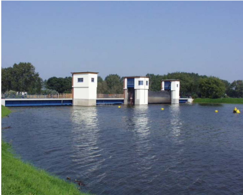
Im Umbau befindliche Wehranlage Gnevsdorf des Landesumweltamtes
