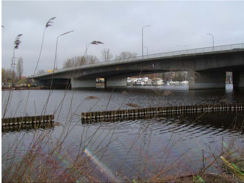
Abb. 3.2.2.-4: Im Brückbau integrierte Messstation Potsdam an der Havel
