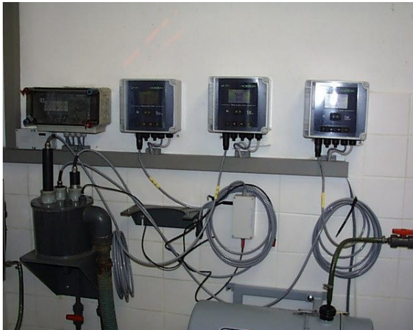
Abb. 3.2.1.-6: Messsystem Sauerstoff, pH-Wert und Leitfähigkeit
