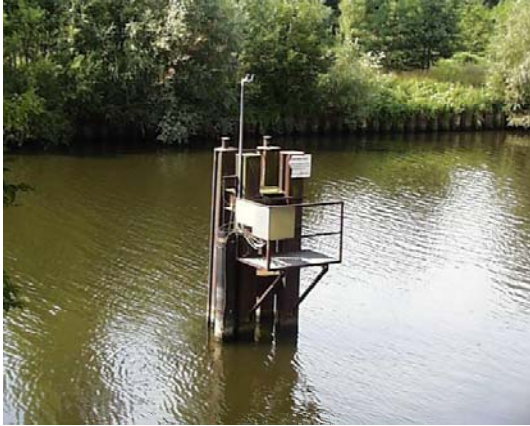
Abb.3.2.1. -2: Entnahmestelle im Teltowkanal
