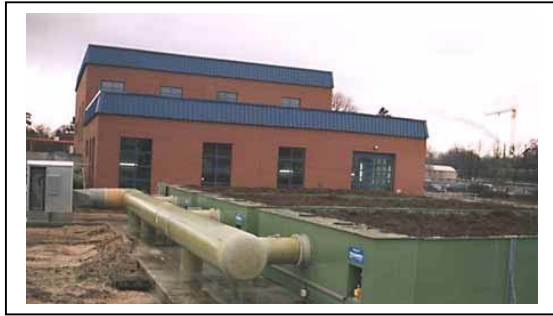
Abb. 1: Beispiele für offene Biofilter (Quelle: Tholander Ablufttechnik GmbH)
