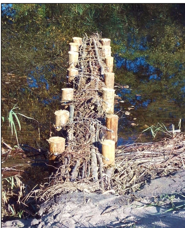
Fertige Buhnen bei sehr niedrigem Wasserstand (Buhnenoberkanten auf Mittelwasser-Niveau)
