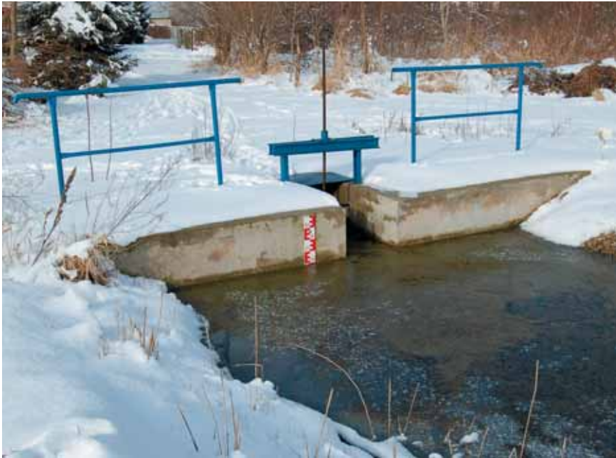
Abb. 8: Wintereinstau auf der Marstallwiese im Februar 2009, nach Sanierung des Staubauwerkes Foto: H. Rößling
