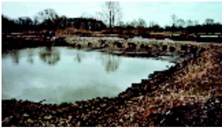
Abb. 3 Unterer Teil der Baugrube am 17.3.05 mit Blick auf Fangedamm und Spundwand
