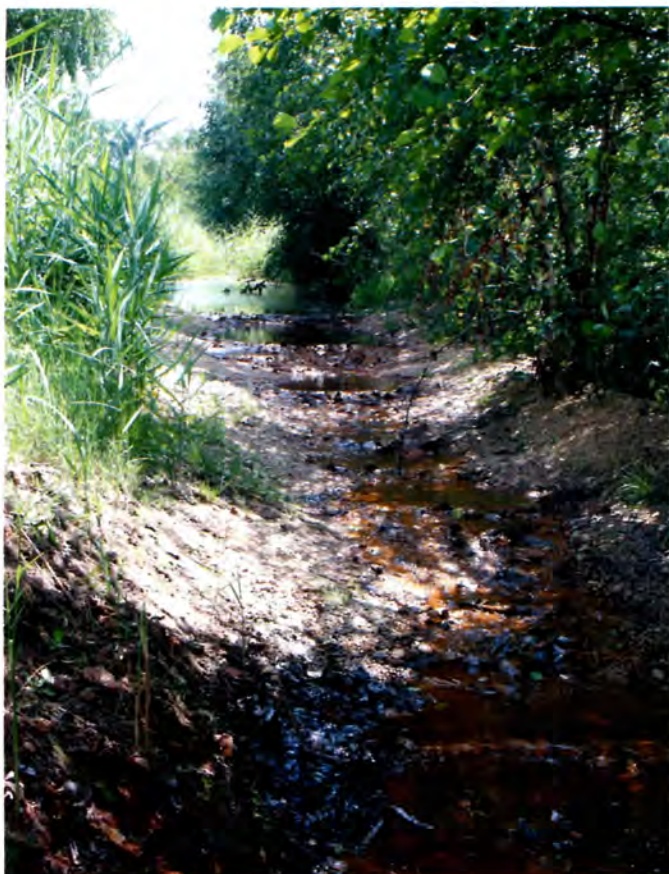
Abb. 4 Stützschwelle zum Wasserrückhalt im Fuchsteichgraben
