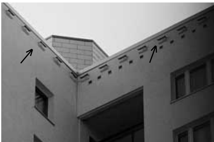
Abb. 9 Mauerseglernistkästen der Fa. Schwegler an einem Hochhaus in Potsdam Foto: M. Zerning
