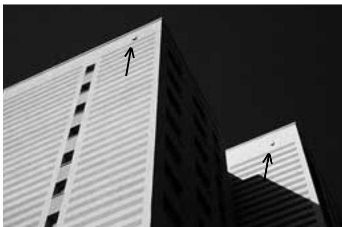
Abb. 12 Fledermausquartiersteine von Strobel an einem Hochhaus in Potsdam; die großräumigen Winterquartiere liegen je nach Variante innerhalb der gedämmten Wand oder im Drempebereich Foto: M. Zerning
