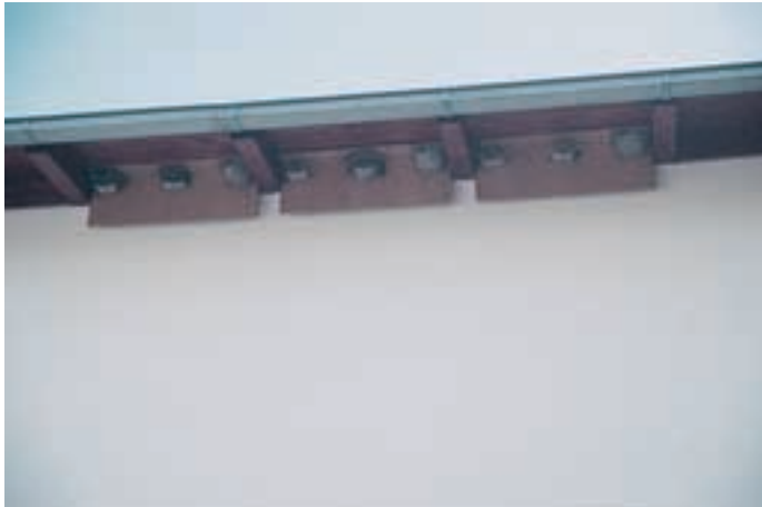
Abb. 6 „Mehlschwalben- bretter“ zur gezielten Lenkung der Ansiedlung an fensterarmen Wänden von Wohnhäusern; besonders eindrucksvoll bei dieser Variante ist die geringe Verschmutzung der Wand nach Brutende. Foto: M. Zerning
