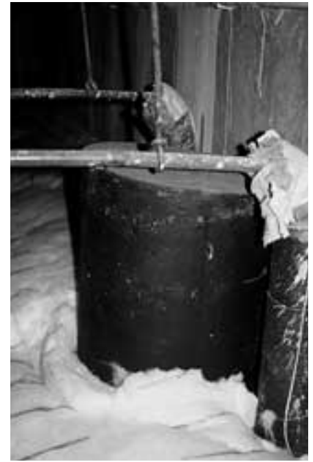
Abb. 14 Großraumfledermausquartier von Schwegler im Drempebereich eines Hochhauses direkt an den Wanddurchbruch nach außen gesetzt (Abb. 17) Foto: M. Zerning
