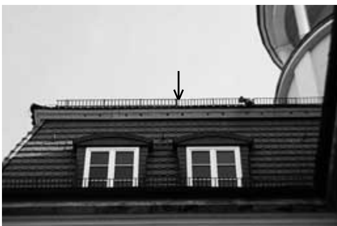
Abb. 10 Mauerseglerniststätten in die erneuerten Dachkästen integriert Foto: M. Zerning
