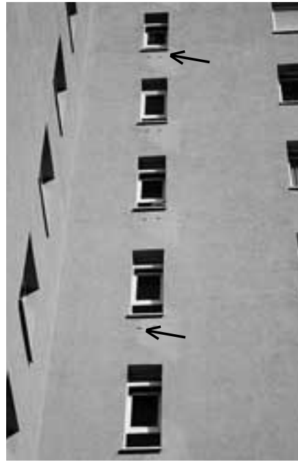
Abb. 13 Fertige Fassade mit zehnmal je zwei Einflügelöffnungen unter Abstellkammerfenstern an einem Hochhaus; jede Einheit besteht aus 3 feuerfesten Fledermausziegeln aus Lehm, die untereinander verbunden sind Foto: M. Zerning
