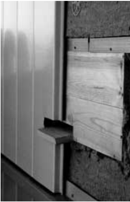
Abb. 11 Fledermausquartier aus Holz in die Fassadendämmung der Außenwand integriert Foto: J. Teuber
