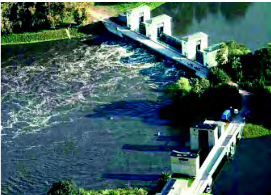
Abb. 1 Einlasswehr Neuwerben während der Kappungsphase am 21.8.2002
