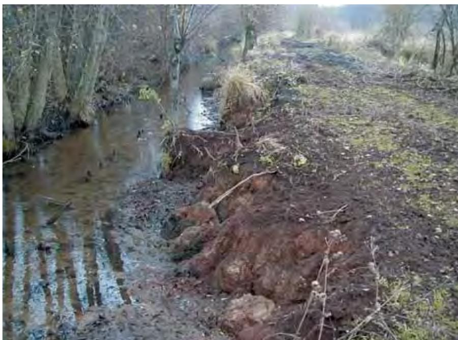
Abb. 16: Der Stranggraben in den Langen Dammwiesen zeigt infolge tiefer Entwässerung Böschungserosion
