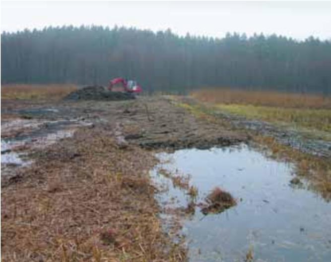
Abb. 11: Die Verfüllung von geneigten Gräben mit gewachsenen Torfaggregaten zeigt gute Ergebnisse hinsichtlich der Lagestabilität und Stauwirkung (Kunstertal bei Neuruppin) Foto: J. Thormann
