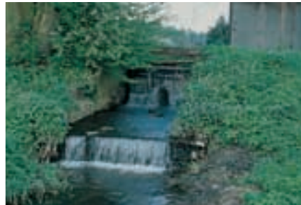
Abb. 2 Sohlstufen in kleinen Fließgewässern (hier in Fläming, Verlorenwasser) sind für Fische unüberwindbare Barrieren. Foto: D. Knuth
