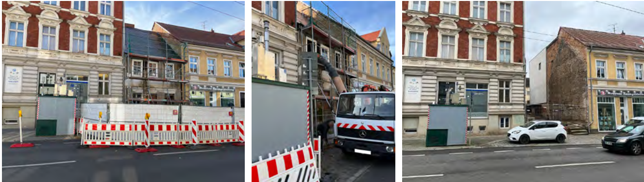
Abbildung 32: Aufnahmen in der Breiten Straße in Eberswalde während und nach den Bauarbeiten im Jahr 2022 © M. Michna-Dohm
