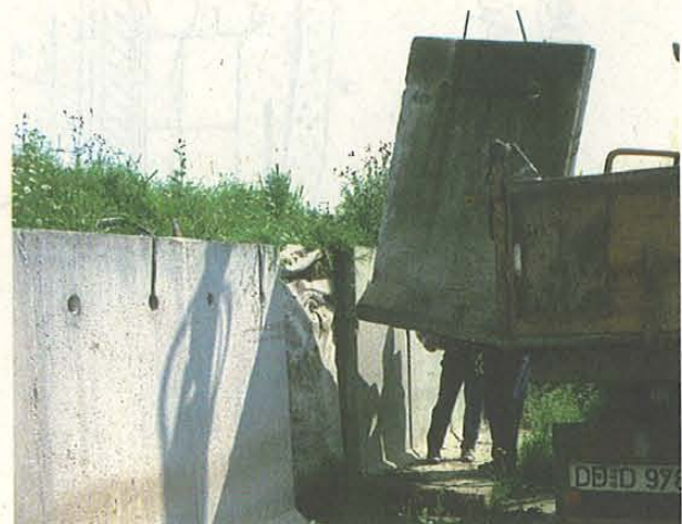
Abb. 3 Ausheben des ersten Winkelstützelements
