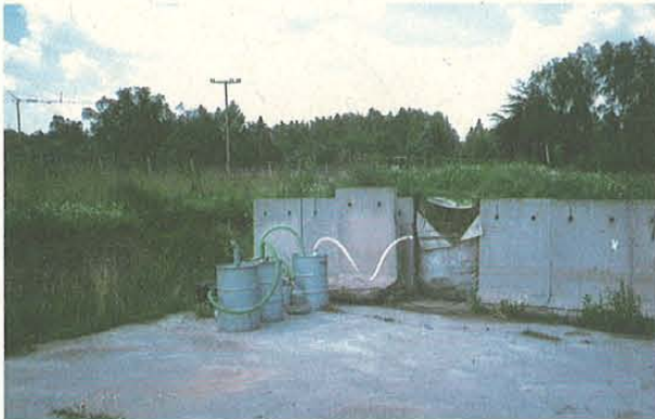
Abb. 5 Deponieluftabsaugung
