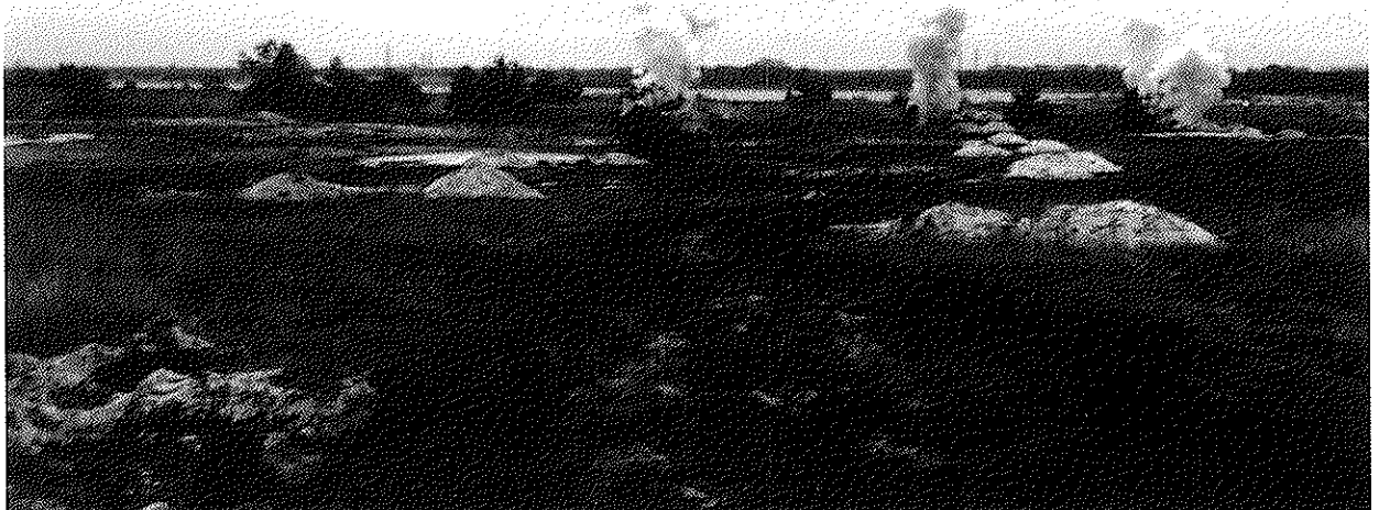
Bild 4 Sprengfeld beim „Abtun der Ladungen“. Das Feld wurde vor dem Sprengen geräumt und das Zünden erfolgt mit Standort im sicheren uferfernen Hinterland – „Detonationsdruckphase“.
