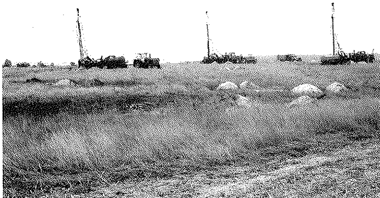
Bild 2 Abteufen der Sprengbohrlöcher in einem bestimmten Raster Im Vordergrund Aushubmassen aus den Bohrspülungsgruben; im Hintergrund Drucksonde im Einsatz.
