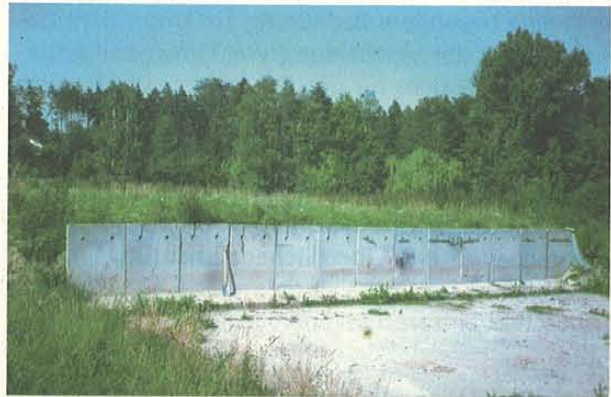
Abb. 1 Ansicht des Sonderabfall-Lagers, Südseite
