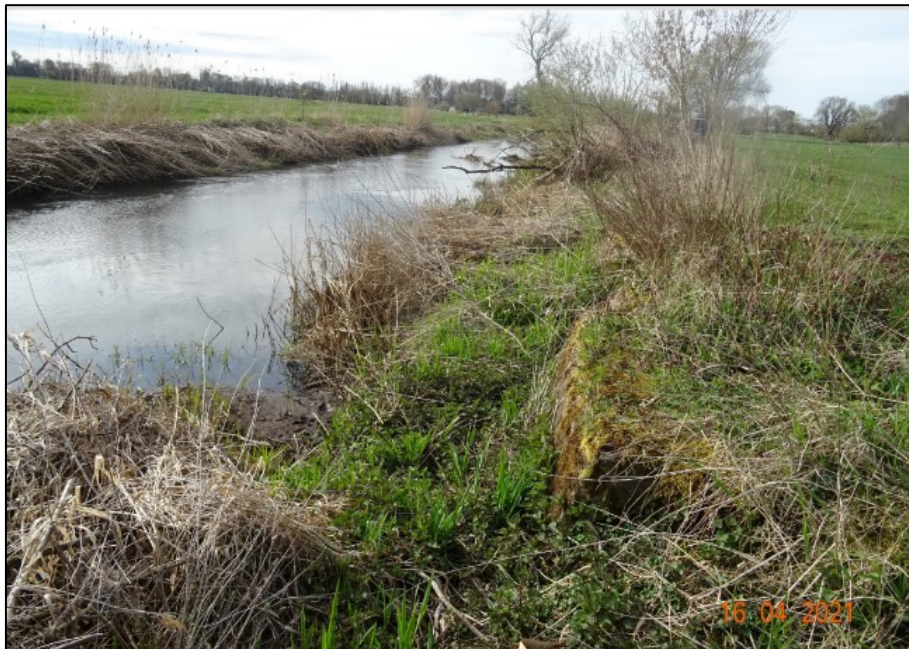
vorher: Ufer mit Einlaufbauwerk
