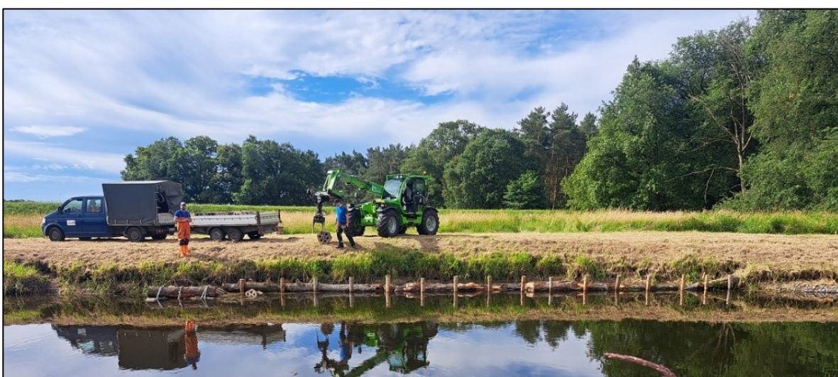
Zwei von zehn Stammholzbindeln, die am Böschungsfuß eingebaut wurden.
