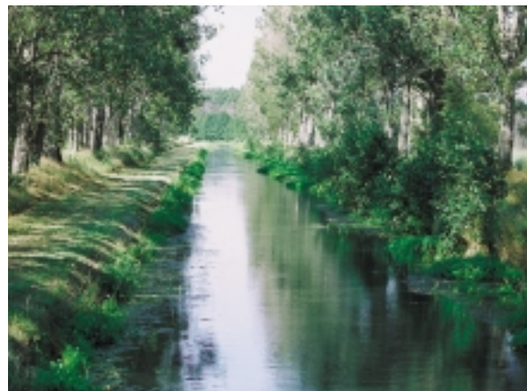
Abb. 4.1.1.2-4: Erheblich verbauter Abschnitt der Nuthe bei Liebätz (Foto: A. HICKISCH, 2003)
