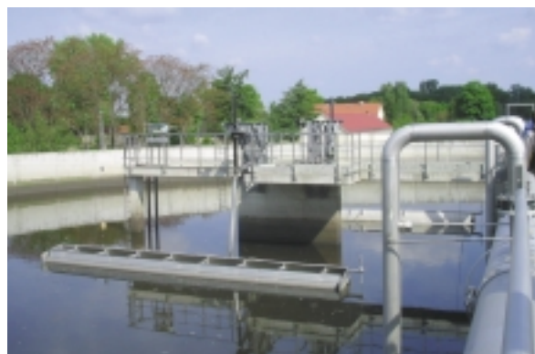
Abb. 4.1.4.1-1: Belebungsbecken der Kläranlage Potsdam (Foto: H. ANGERMANN, 2005)
