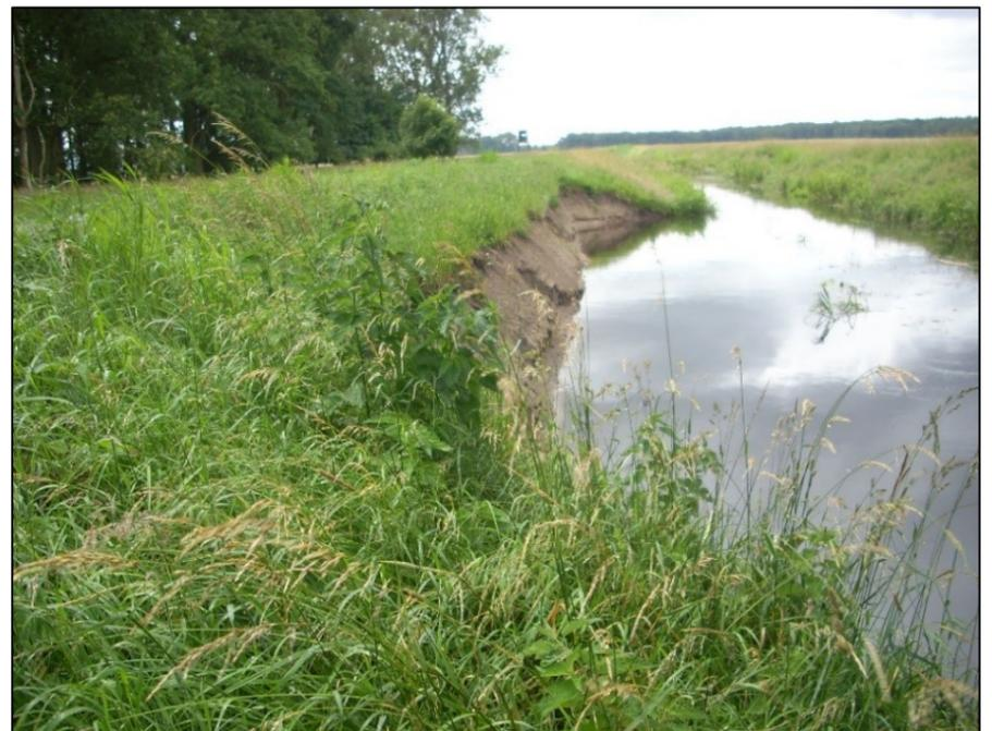
**Profilaufweitung mit Flachwasserzone und Steilufer 2024**
