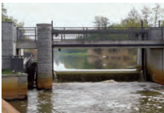
Abb. 7-1: Im Jahr 2003 neu errichtetes Wehr Bad Liebenwerda (Ersatzneubau) in der Schwarzen Elster mit Fischaufstiegsanlage sowie Passage für Otter und Biber (Foto: O. Wiemann)
