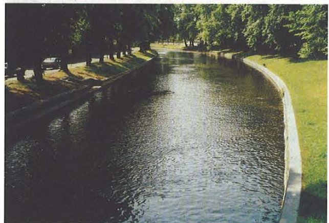
Abb. 46: Ausbaustrecke der Stepenitz in Perleberg, LK Prignitz; senkrechte Stein/Betonuferböschung. (S. Ochmann, 27.07.1995)
