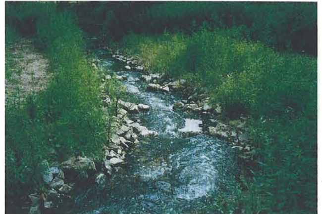
Abb. 18: Stöbber, Umgehung des Staus der Eichendorfer Mühle durch Fischpaß, LK Märkisch-Oderland. Große Steine sind durch Beton festgelegt. Aufwärtswanderung von Makrozoobenthon durch Stauschütz und oberhalb liegendem wiederangestauten Teich zum Scheitern verurteilt. Fließgewässerorganismen sterben im Teich ab; als Fischpaß voll funktionsfähig, trotzdem starke Beeinträchtigung. (R. Scharf, 02.07.1992)
