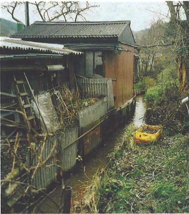
Abb. 32: Hammerfließ, wilder Verbau mit senkrechten Eisen- und Blechplatten, Kleingärten oberhalb Bundesstraße 167, LK Barnim. (S. Ochmann, 20.11.1996)
