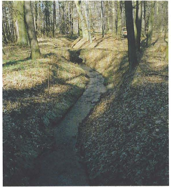
Abb. 33: Steinitzer Wasser oberhalb Drebkau, LK Spree-Neiße, Bachauskleidung mit Rasengitterplatten, Sohle z.T. noch aus natürlichem Substrat. (S. Ochmann, 22.02.1995)
