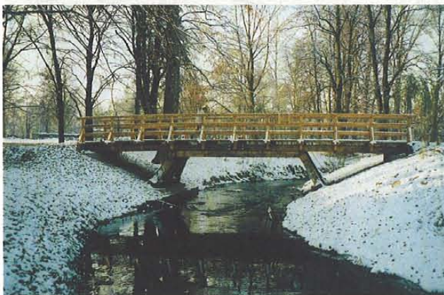
Abb. 26: Brücke über die Dömnitz in Pritzwalk, LK Prignitz. Geringe Beeinträchtigung durch Uferbefestigung im Brückenbereich. (S. Ochmann, 22.11.1995)
