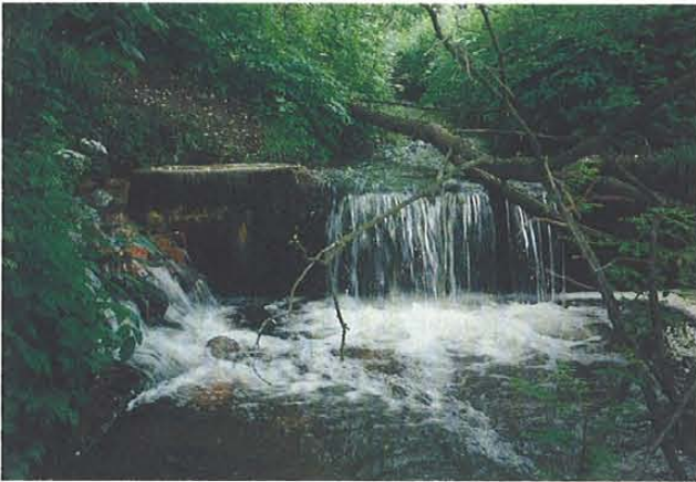
Abb. 13: Batzlower Mühlenfließ, 1,5 km westlich Gottesgabe, LK Märkisch Oderland. Sohlabsturz wurde durch die zu steile Sohlrampe (links) etwas gemildert, langgezogene Sohlrampe empfehlenswert, starke Beeinträchtigung. (R. Scharf, 07.06.1994)
