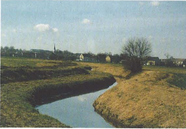
Abb. 43: Hopfengartenbach/Querbach unterhalb Großthiemig, LK Elbe-Elster; stark ausgebaut und eingedeicht, sehr langsamfließend, einheitliches Profil, keine Beschattung. (S. Ochmann, 22.03.1995)
