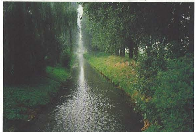
Abb. 38: Nuthe in Woltersdorf, LK Teltow-Fläming. Die Ufer- befestigung durch hinterspülte und im Zerfall be- griffene Faschinen stellt keine Beeinträchtigung für die Durchgängigkeit dar.
