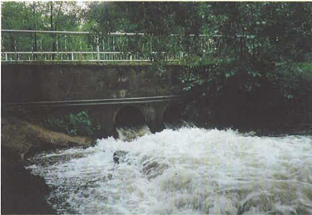
Abb. 20: Rohrdurchlaß für den gesamten Rhin bei Rheinhausen, LK Ostprignitz-Ruppin. Rohrdurchlässe sind für nahezu alle Fließgewässerarten lebensfeindlich und kaum passierbar. Die hohen Fließgeschwindigkeiten machen den Durchlaß auch für Fische unpassierbar (wurde inzwischen umgebaut). (R. Scharf, 30.09.1994)
