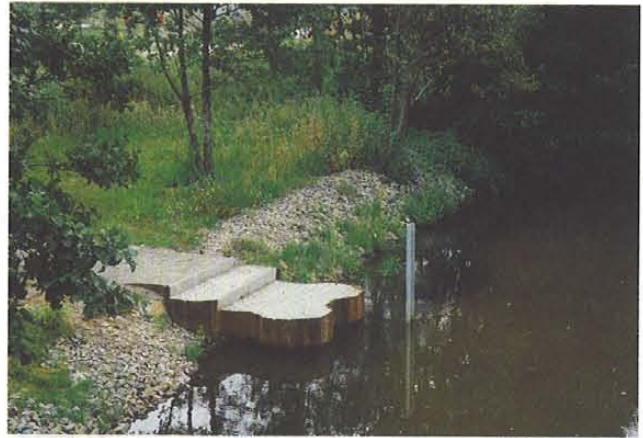
Abb. 36: Pulsnitz am Ortseingang von Ortrand, LK Oberspreewald- Lausitz; Steinschüttung und kurze Spundwand zur Stabil- haltung des Pegelprofils. Wegen der Kürze der Strecke nur geringe Beeinträchtigung. (R. Scharf, 28.08.1996)
