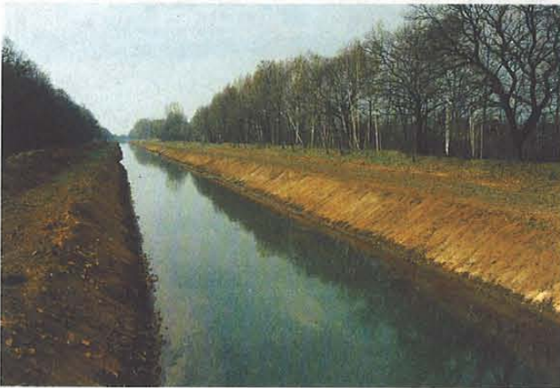
Abb. 45: Schwarze Elster unterhalb Brieske, LK Oberspre- e-Lausitz. Zeitweise sehr naturferner Zustand als Ergeb- nis unzeitgemäßen Gewässerausbaues. Böschungsges- taltung und Beseitigung aller Gehölze sowie der ge- samten Ufervegetation durch Gewässerunterhaltungs- verband. (E. Jakubik, April 1993)
