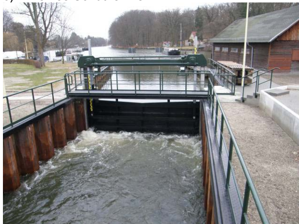
Abb. 136: Kleines Schützenwehr Neue Mühle
