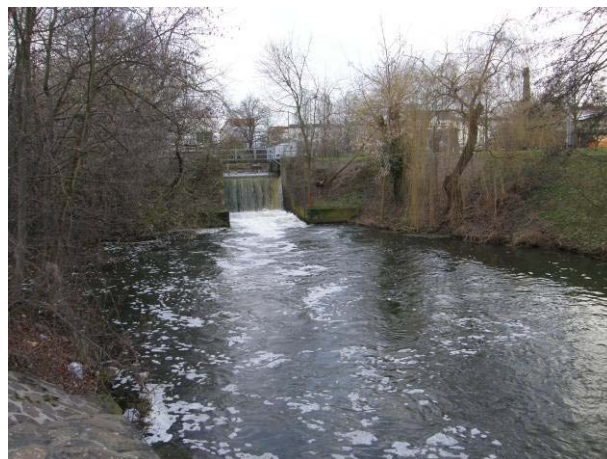
Abb. 113: Wehr Eberswalde (Unterwasser)
