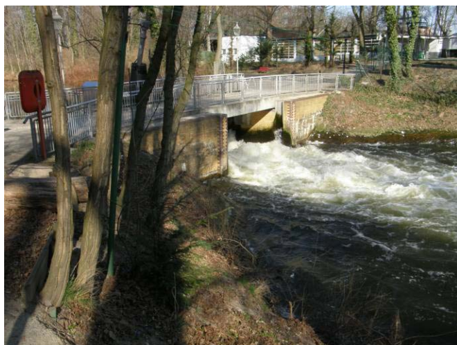
Abb. 35 + 35a: Zitadellen-Wehr in Berlin-Spandau
