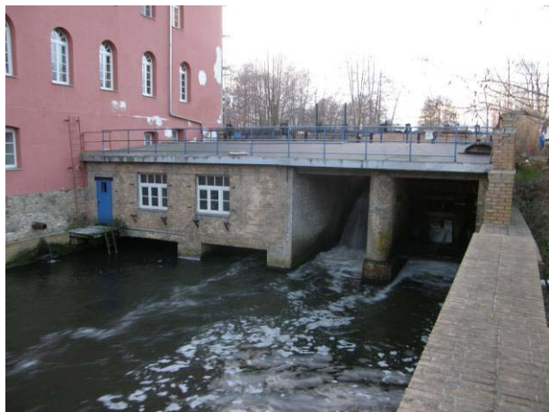
Abb. 128: Wehr + WKA Schöpfurth (Unterwasser)
