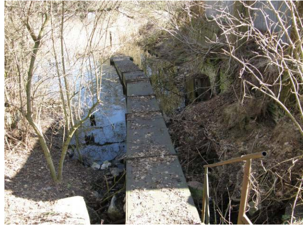
Abb. 173: Ablauf Rohrdurchlass Tornow
