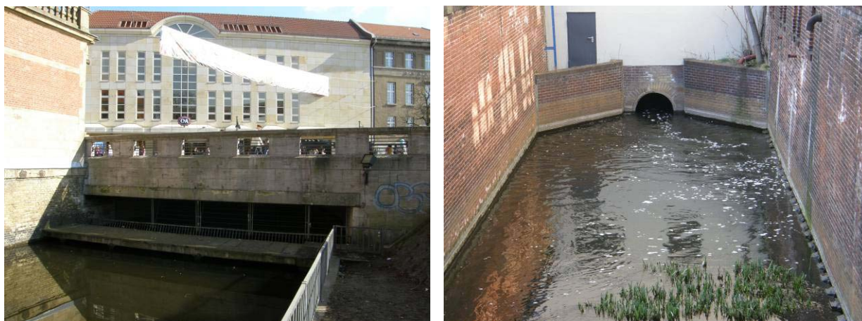
Abb. 36 + 36a: Wehr Mühlgraben Spandau (links: Oberwasser mit Rechen; rechts: Unterwasser mit Rohrdurchlass)
