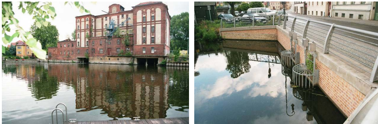
Abb. 26 + 26a: Krakauer Mühle in Brandenburg - links: Unterwasser; rechts: Oberwasser
