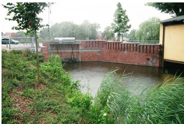
Abb. 22 + 22a: Doppelrohrdurchlass des Reissnerschen Gerinnes, Dom-Insel Brandenburg (links Oberwasser; rechts Unterwasser – links davon Auslauf des Rechteckgerinnes)
