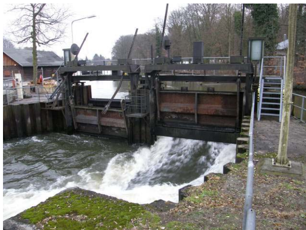
Abb. 134: Fischbauchklappenwehr Neue Mühle
