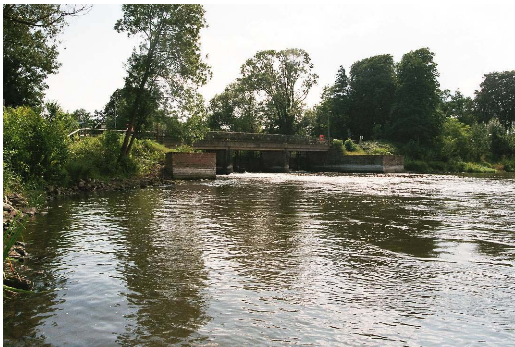
Abb. 12: Wehr Hinterarche Rathenow
