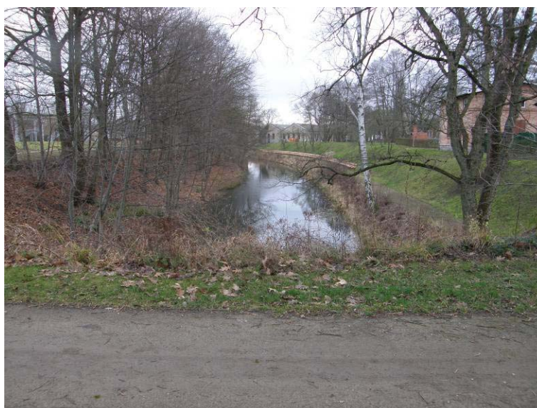
Abb. 120: ehemaliger Ablaufgraben WKA Drahthammer
