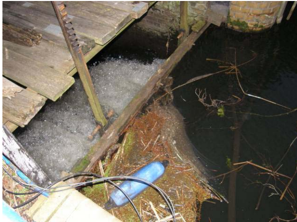
Abb. 130 (oben): Linker Wehrverschluss
