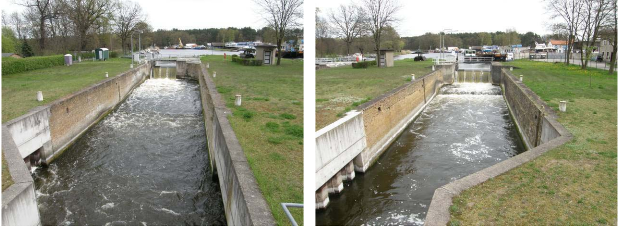
Abb. 45 + 46: Schleusen Malz - links: Wehr Malz I (Freiarche); rechts: Wehr Malz II
