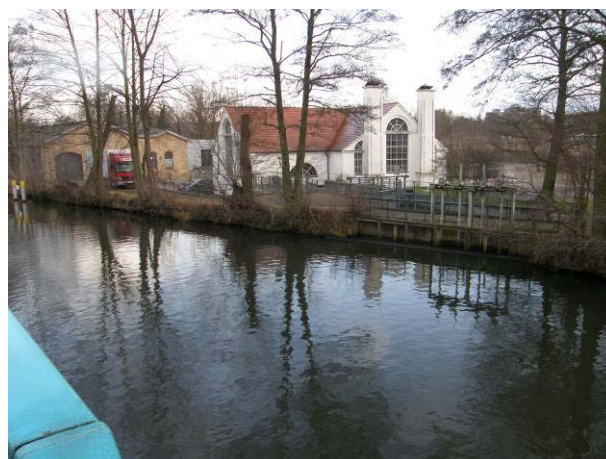
Abb. 119: ehemaliges Wehr WKA Drahthammer
