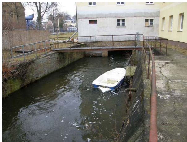
Abb. 157: Wehr Woltersdorf (Unterwasser)
