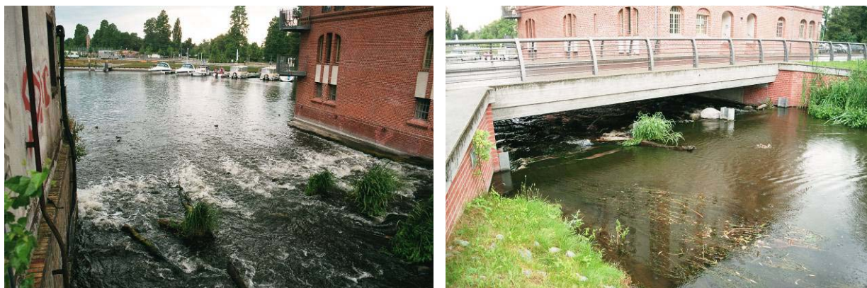
Abb. 27 + 27a: Großer Überfall in Brandenburg - links: Unterwasser; rechts: Oberwasser
