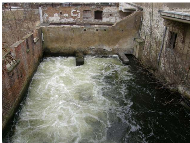
Abb. 78: Wehr Brandenburger Straße (Unterwasser)
