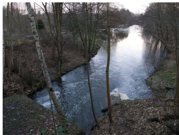
Abb. 116: Wehr Kupferhammer (Unterwasser)
