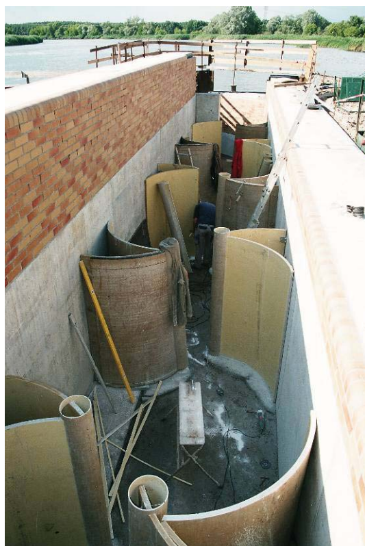
Abb. 18 + 18a: Mäander ® -Fischpass am Wehr Bahnitz im Bau (20.07.2009) bzw. als Prinzip-Skizze (Fa. Ökofisch Peters; Typ H)
