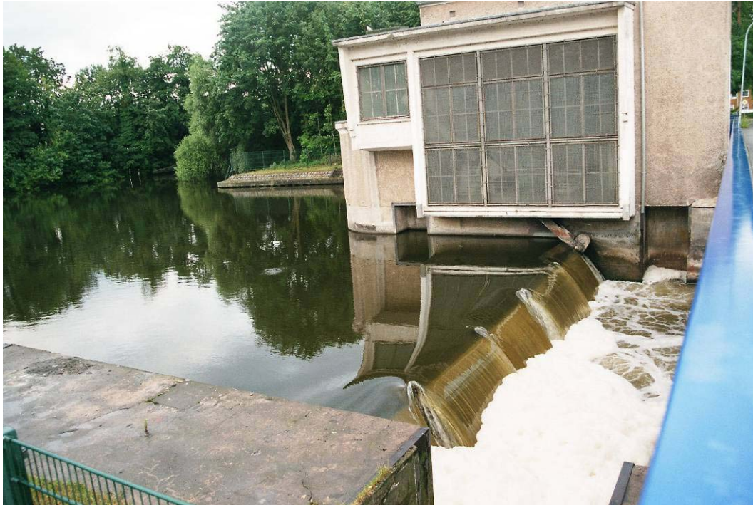
Abb. 20: Großes Wehr Brandenburg, Blick auf das rechte Wehrfeld
