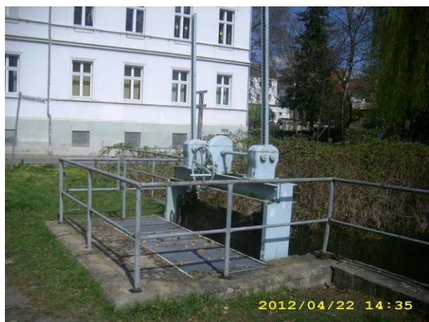
Abb. 24 + 24a: Rohrdurchlass Grabenstraße in Brandenburg (Pumpergraben) – rechts Unterwasser
