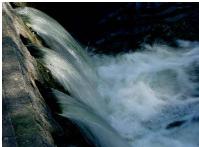
Abb. 39: Wehr Östlicher Abzugsgraben (Foto: Jaroslaw Noworyta® – google-earth)
