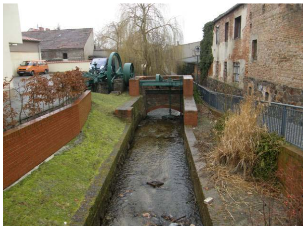
Abb. 147: Mühlenwehr Storkow (Oberwasser)
