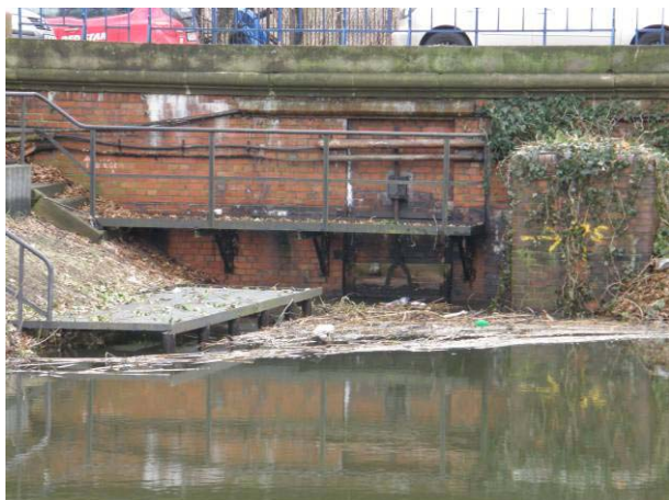
Abb. 94: Mühlen-Wehrschütz (Oberwasser)
