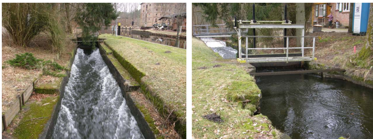
Abb. 82 + 82a: Freiarchenwehr Steinhavel (links: Unterwasser; rechts: Oberwasser)
