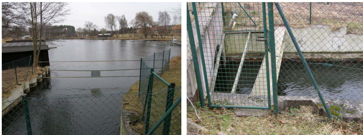
Abb. 73 + 73a: WKA Bredereiche – Oberwasser (Einlauf) -Situation
