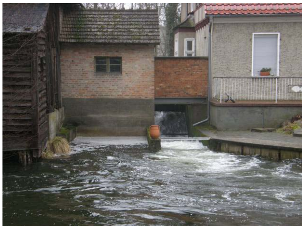
Abb. 140: Mühlenwehr Kummersdorf (Unterwasser)
