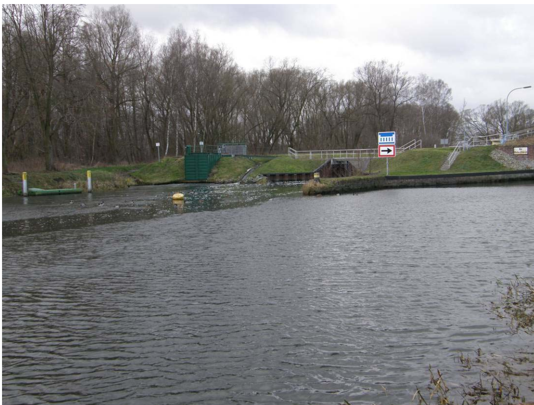
Abb. 104: Wehr Stecher mit rechtsseitiger Wasserkraftanlage, Vertikal-Schlitzpass und Bypass
