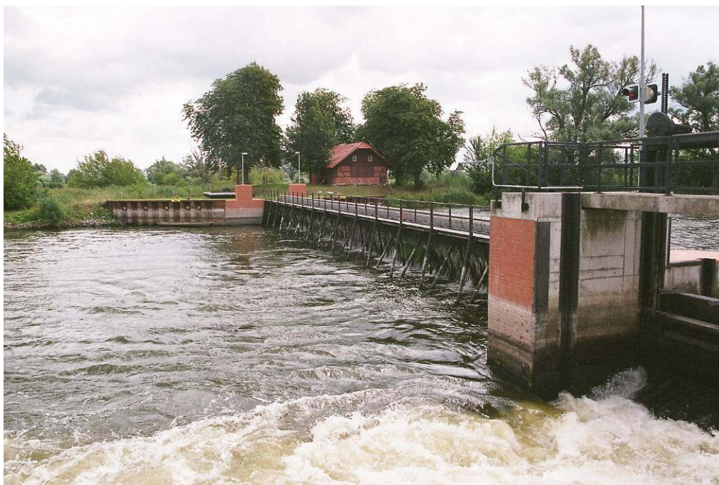
Abb. 8: Nadelwehr Garz (rechts: linksseitige Abflussregulierung über Schützenwehr)
