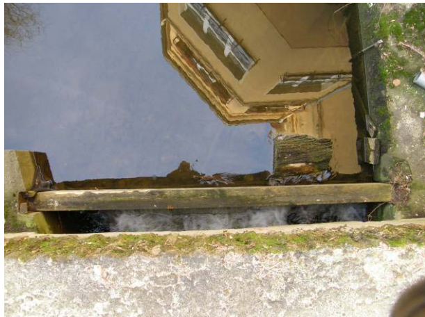
Abb. 163: Dammbohlenverschluss Templin
