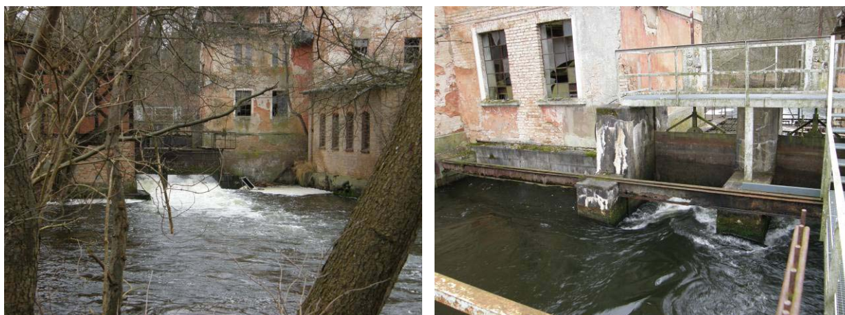
Abb. 80 + 80a: Mühlenwehr Steinhavel (links: Unterwasser; rechts: Oberwasser)
