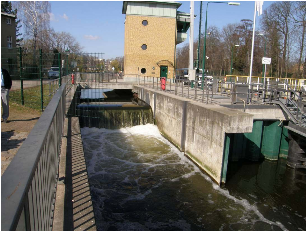
Abb. 34: Freiarchenwehr an der Schleuse Spandau
