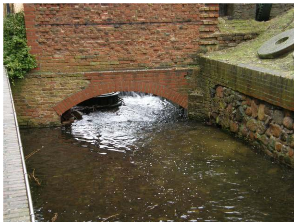
Abb. 148: Mühlenwehr Storkow (Unterwasser)
