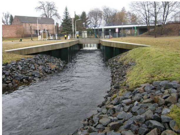
Abb. 151: Wehr Wendisch Rietz (Unterwasser)
