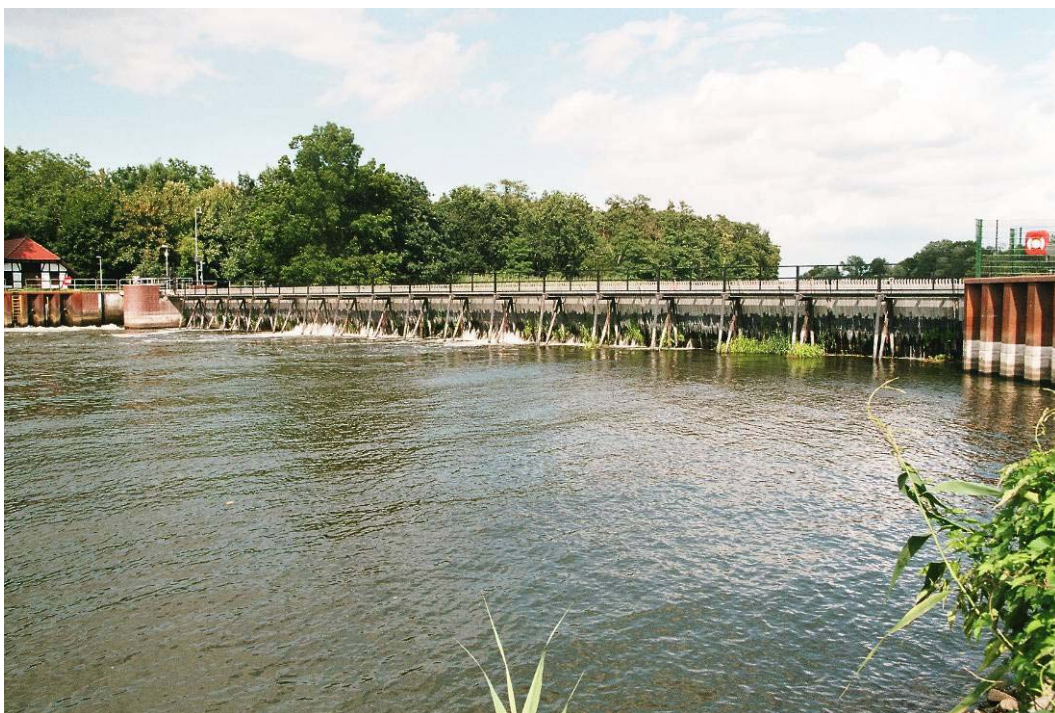
Abb. 10: Nadelwehr Grütz (links: rechtsseitige Abflussregulierung über Schützenwehr)
