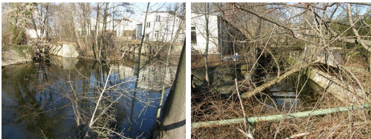
Abb. 37 + 38: Wehranlagen im Westlichen Abzugsgraben (links: Nr. 4a+b; rechts: Nr. 4c)
