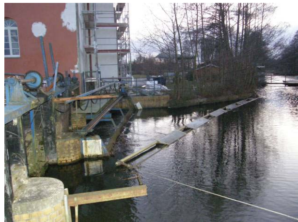
Abb. 129: Wehr + WKA Schöpfurth (Oberwasser)
