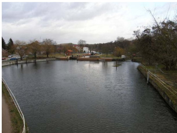
Abb. 112: Schleuse Eberswalde (Oberwasser)
