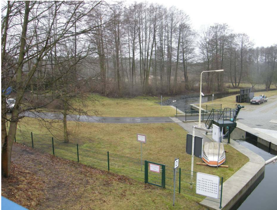
Abb. 152: Wehr Wendisch Rietz (Umfeldsituation)
