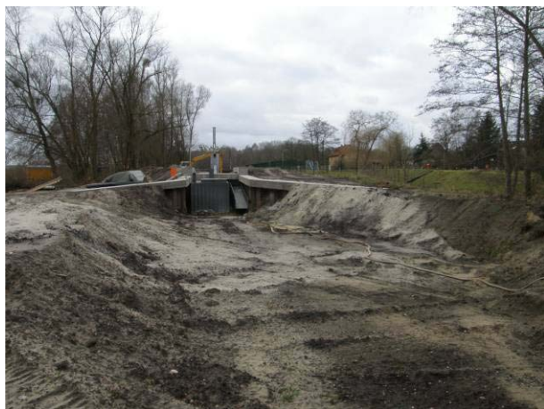
Abb. 101: WKA Liepe (Unterwasserbereich)
