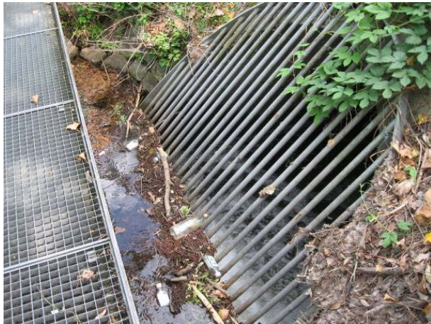
Abb. 28: Einlauf Wehrverschluss Jakobsgaben
