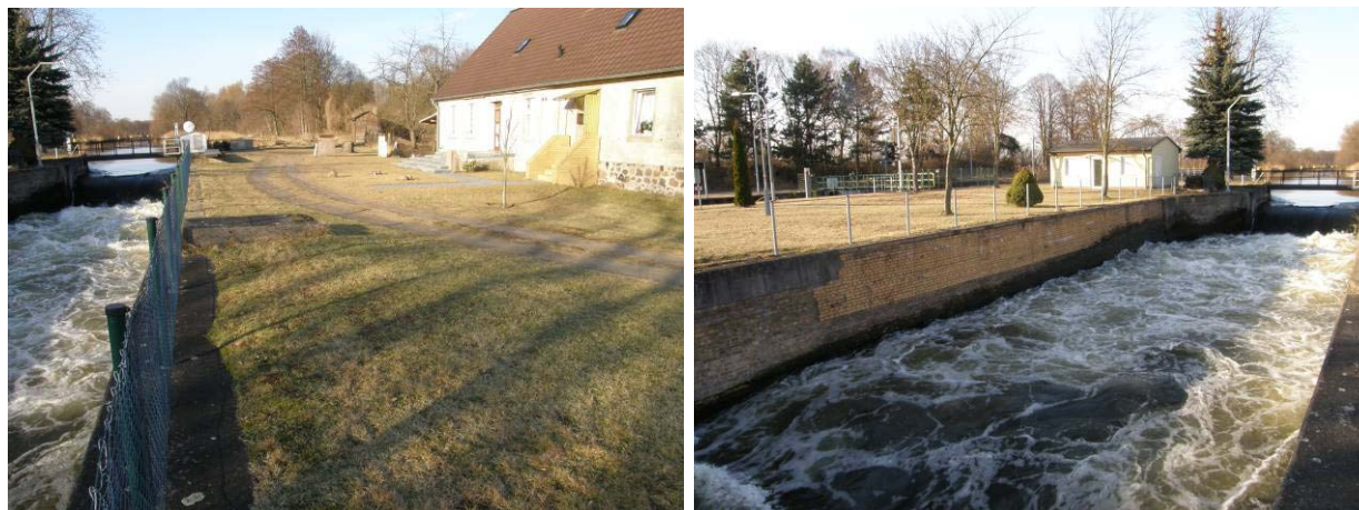
Abb. 49 + 49a: Wehr Liebenwalde (links: linkes Ufer; rechts: rechtes Ufer, im Hintergrund die Schleusenkammer)
