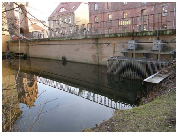
Abb. 161: Wehrgruppe Templin (Oberwasser)
