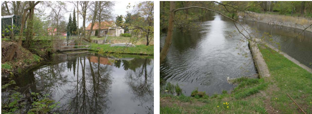
Abb. 44 + 44a: Schleusen-Durchlass Sachsenhausen (links: Oberwasser; rechts: Unterwasser)
