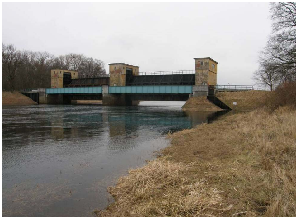
Abb. 6: Wehr Quitzöbel (rechts: rekonstruierter Vertikal-Schlitzpass)
