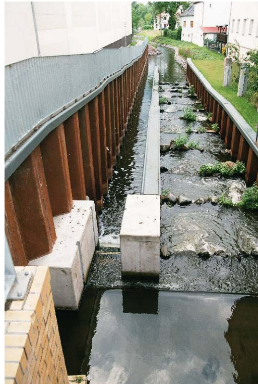
Abb. 25 a-c: Wehr und FWH Mühlgraben Brandenburg – Blick aus dem Unterwasser (links); Blick aus dem Oberwasser (rechts); unten: Staubohlenverschluss und Beton-Sohle
