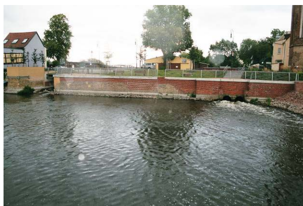
Abb. 22 + 22a: Doppelrohrdurchlass des Reissnerschen Gerinnes, Dom-Insel Brandenburg (links Oberwasser; rechts Unterwasser – links davon Auslauf des Rechteckgerinnes)
