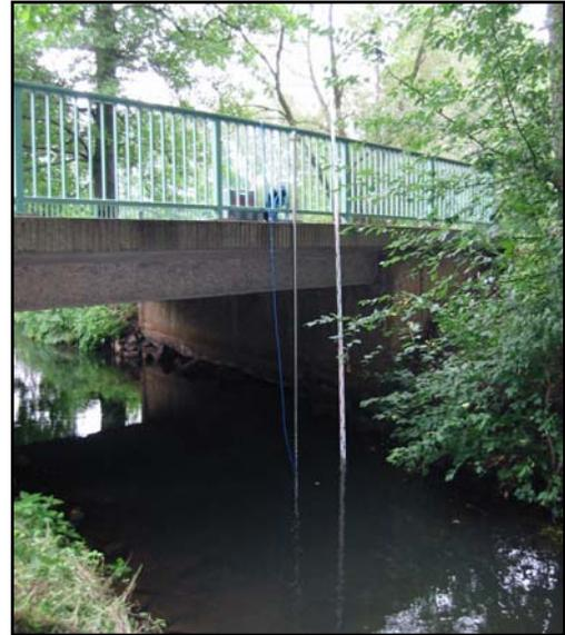
Abbildung 3-5: Gerät zur Durchflussmessung (links) und Einsatzort an der Brücke Ringchausee
