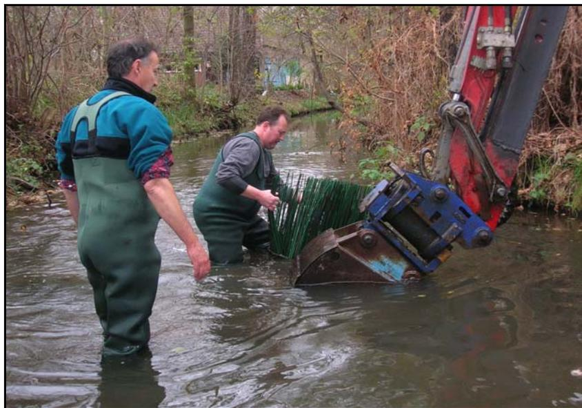
**Abbildung 3-5: Einbau mit Schreitbagger**
