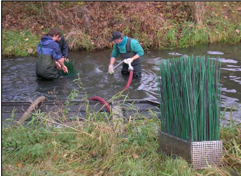
**Abbildung 3-6: Einbau mit Spüllanze**
