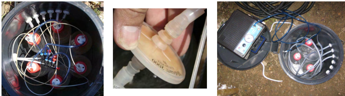
Abbildung 14: links - Servicemodul; mitte – Überlaufschutz; rechts - Servicemodul und Vakuumpumpe
