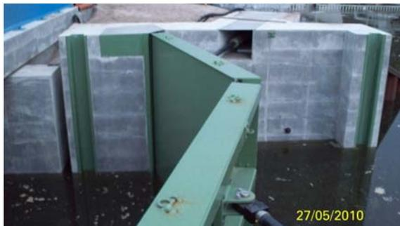
*Abb. 5-26 (li.): Alter Straßendamm mit Foliensicherung und 20 cm Aufkadamung auf 26,20 m NHN – HW-Sicherung (Foto: Ö5, Fromhold-Treu). Abb. 5-27 (re.): Geschlossenes Sperrsiel in der Seestraße – HW-Sicherung (Foto: Ö5, Fromhold-Treu)*
