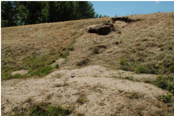
Abb. 4-1: Eingebrochener Biberbau mit Auswaschungen in Ziltendorfer Niederung
