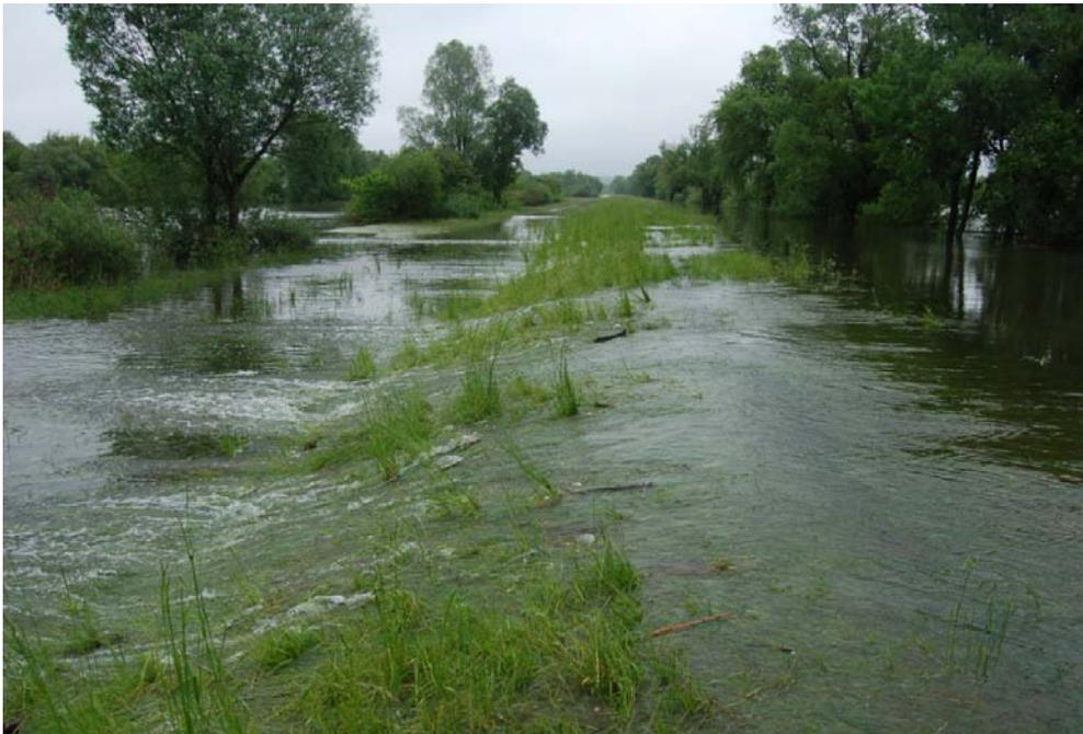
*Abb. 5-15: Überströmung Sommerdeich aus Schwedter Querfahrt zum Polder 10 01. Juni 2010, 07:50 Uhr (Foto: LUGV, RO6, Müller)*
