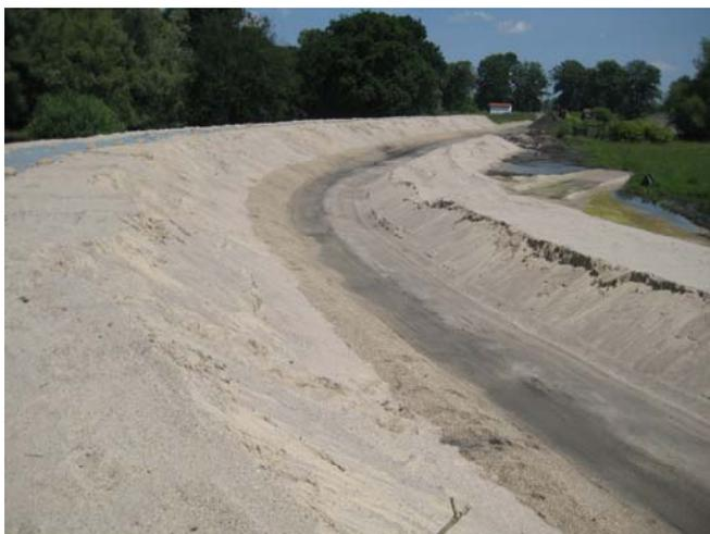
Abb. 5-31: Mit Filterkies und Auflastbank gesicherte landseitige Böschung des Seedeiches bei km 0,5/ Brieskow (Baulos 46) (Foto: LUGV. Ö5, Krüger)
