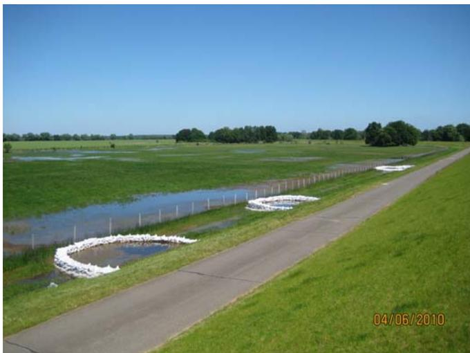
*Abb. 5-10: Mit Quellkaden gesicherter Drängewasseraustritt km 8,1 Ziltendorfer Niederung (Foto: LUGV. Ö5, Krüger)*
