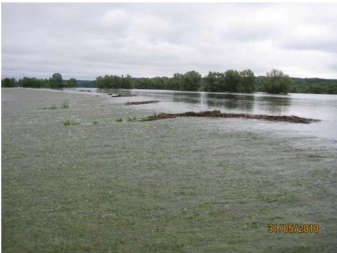
**Abb. 5-17: überströmte Überlaufstrecke im Polder A/B
