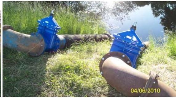
Abb. 5-28 und 5-29: Doppelheberanlage Schlaube / Schustersee für Wasserstandshaltung  $\leq 24,55$  m NHN – HW-Sicherung (Fotos: Ö5, Fromhold-Treu)
