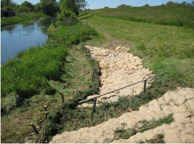
*Bild 5-11: gesicherte Böschungsrutschung am Parallelgraben bei Deich-km 64,7, Oderbruch (Foto: LUGV. Ö5, Krüger)*
