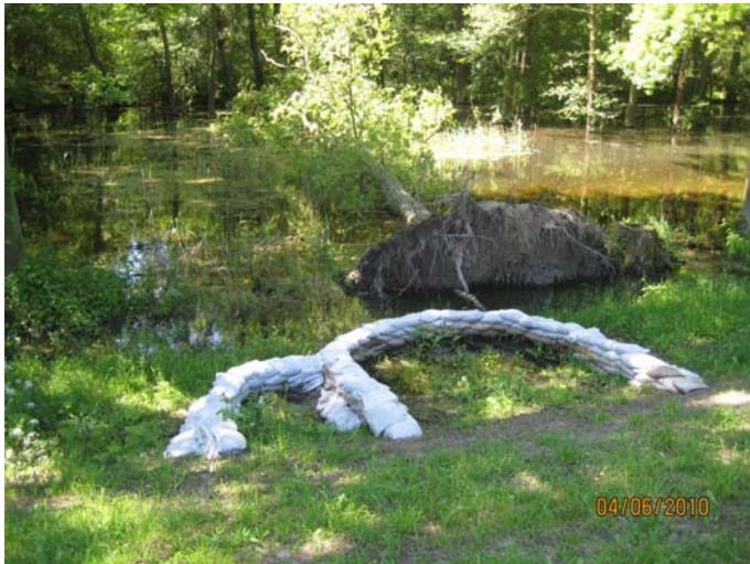
*Abb. 5-9: Mit einer Quellkade gesicherter Drängewasseraustritt bei km 16,55 Ziltendorfer Niederung in Verbindung mit einem Baumwurf (Foto: LUGV. Ö5, Krüger)*
