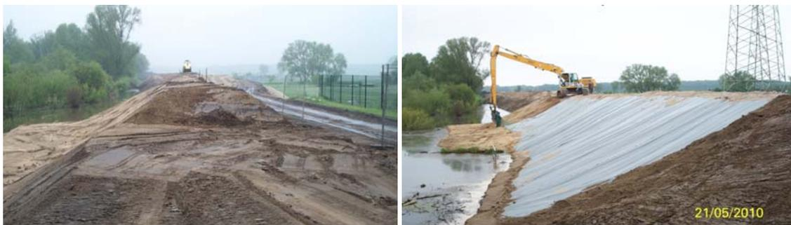
*Abb. 5-22 (li.): Vor HW-Sicherung am Schöpfwerk – Alter Seedeich DOK ca. 24,00 m NHN (Foto: Ö5, Fromhold-Treu). Abb. 5-23 (re.): Alter Seedeich DOK ca. 26,80 m NHN – HW-Sicherung (Foto: Ö5, Fromhold-Treu)*
