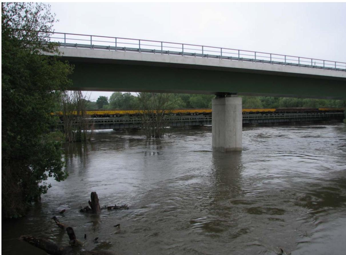
Abb. 5-12: Vorlandbrücken bei Kietz; Eisenbahnbrücke wurde vorsorglich mit Güterzug als Auflast versehen (Foto: LUGV, RO6, Fröhlich)
