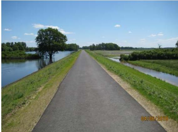
Abb. 5-35 Zustand des Deiches im Baulos 49 beim Hochwasser 2010 – keine Schäden (Foto: LUGV, Ö5, Krüger)
