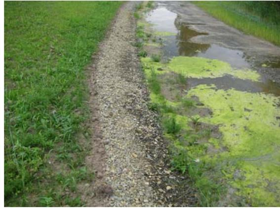
**Abb. 5-5: Sickerwasseraustritte am Deichfuß – ungefährlich. a) Lunow-Stolper-Polder, km 86,0 (Foto: LUGV. Ö5, Krüger) b) Neuzeller Niederung km 3,0 (Foto: LUGV. Ö5, Krüger)**
