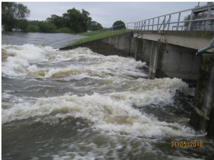
Abb. 5-13: Geöffnetes Flutungsbauwerk km 681,5 - Polder A
