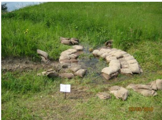
Abb. 5-36: Ungenügend gesicherte und markierte Drainageausmündung (Foto: LUGV, Ö5, Krüger)
