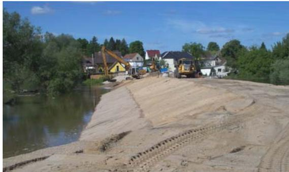
*Abb. 5-24 (li.): Vor HW-Sicherung Seestraße – Alter Straßendamm mit offener Böschung (Foto: Ö5, Fromhold-Treu): Abb. 5-25 (re.): Alter Straßendamm mit Filtersicherung an offener Böschung auf 25,50 m NHN – HW-Sicherung (Foto: Ö5, Fromhold-Treu)*
