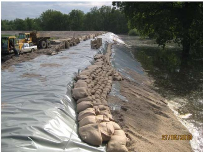
Abb. 5-30: Provisorische Aufkantung und Abdichtung des Seedeiches bei km 0,5/ Brieskow (Baulos 46) (Foto: LUGV. Ö5, Krüger)
