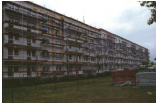
*In die Wärmedämmung eingebaute Fledermauskästen an Plattenbauten in Eberswalde (Teubner)*
