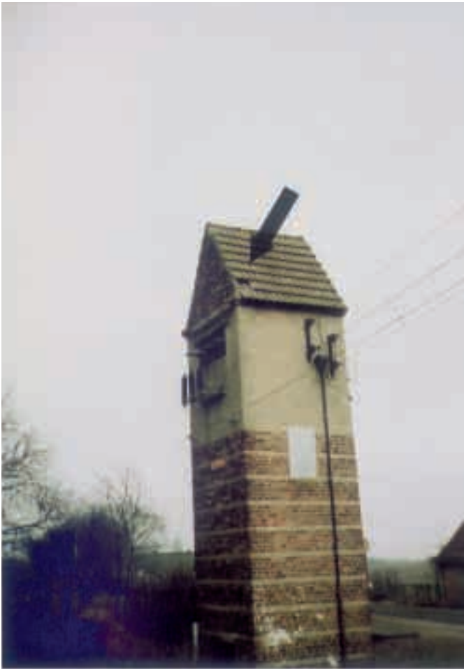
Abb. 2 Trafohaus in Wilmersdorf, Kreis Angermünde Foto: H. Schmidt
