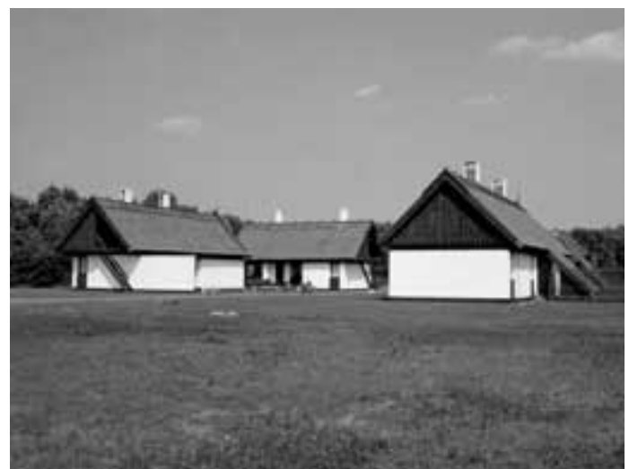
Abb. 5 Die Gebäude der Station des Landschaftsschutzgebietes Dévaványa Foto: I. Kurpé
