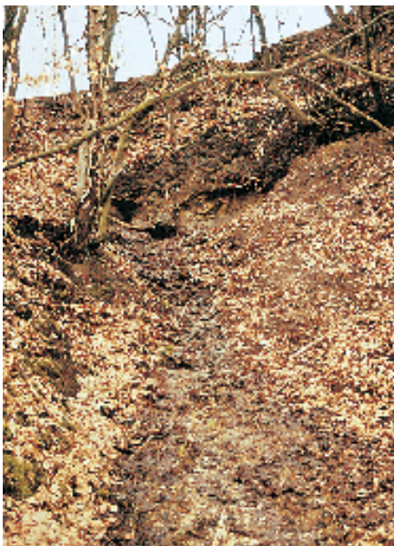
Abb. 1 Sturzquelle bei Reitwein Die Quelle tritt aus dem oberen ungedeckten Grundwasserleiter über den verhärteten Mergel aus. Foto: K. Krüger
